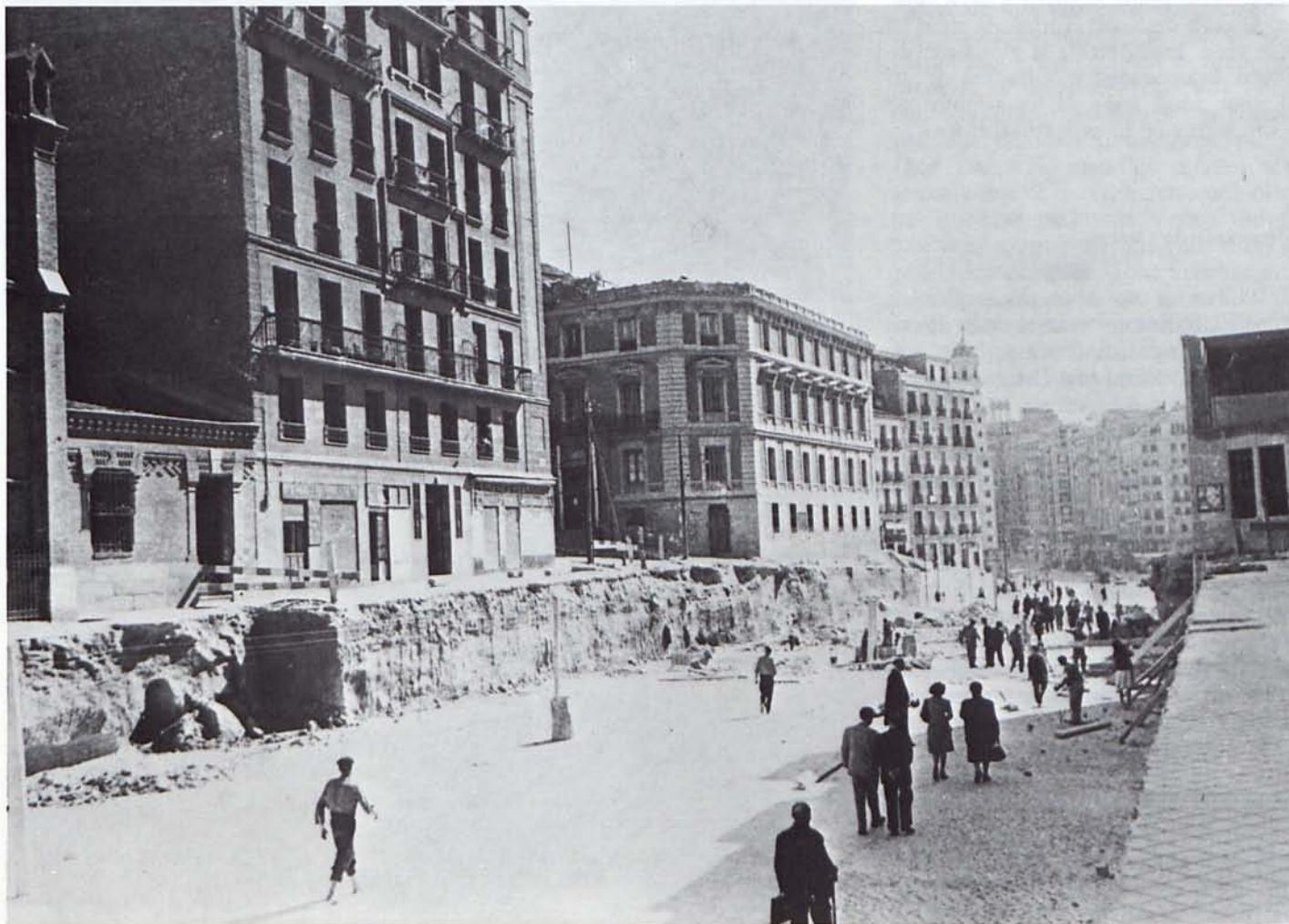
Obras del quinto tramo de la Gran Vía.
