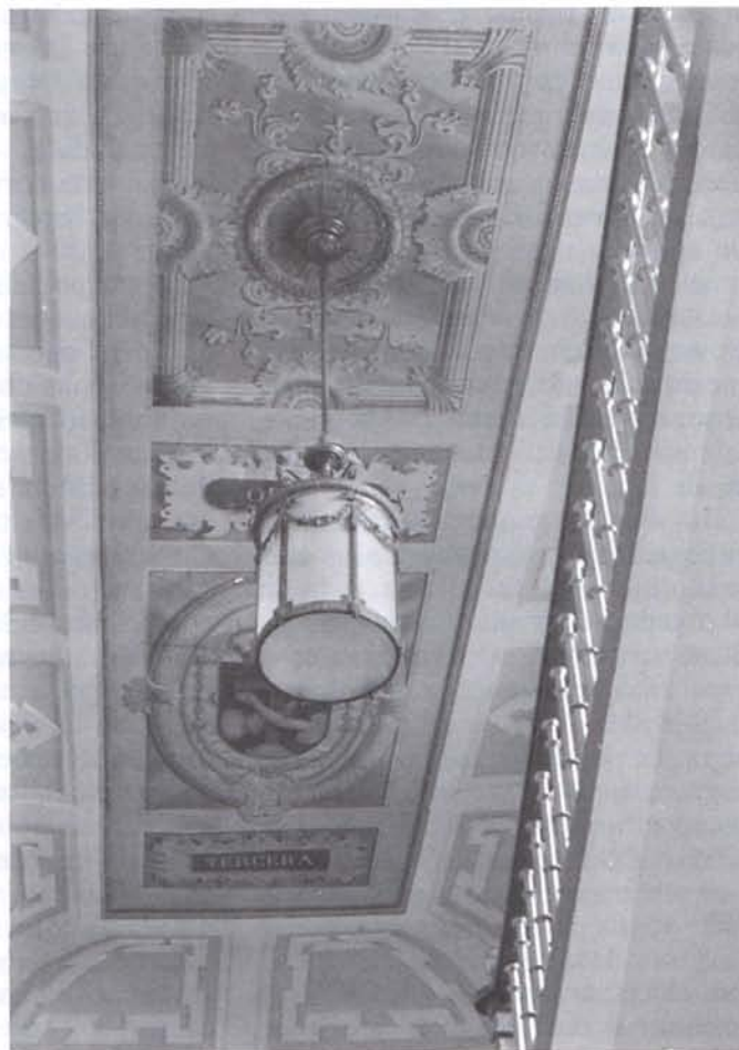
Techo de la escalera de la enfermería.
