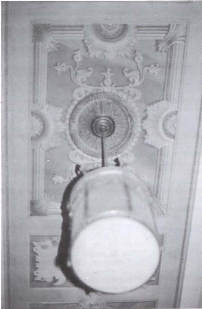
Recuadro central de la pintura en la escalera de la Enfermería.
