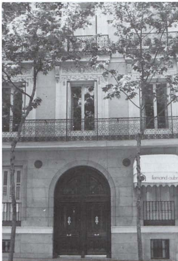
Marqués de Cubas. Fachada Plaza de la Independencia, 8.
