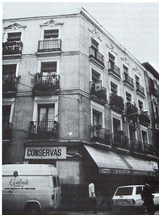
Fachadas de la casa a las calles de San Mateo y San Lorenzo.
