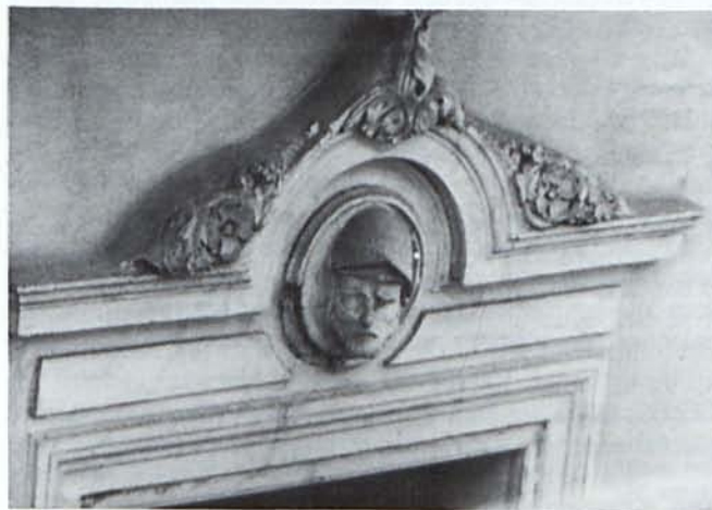
Detalle ornamental de los balcones.
