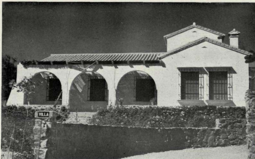
Fachada principal de la solución C.
