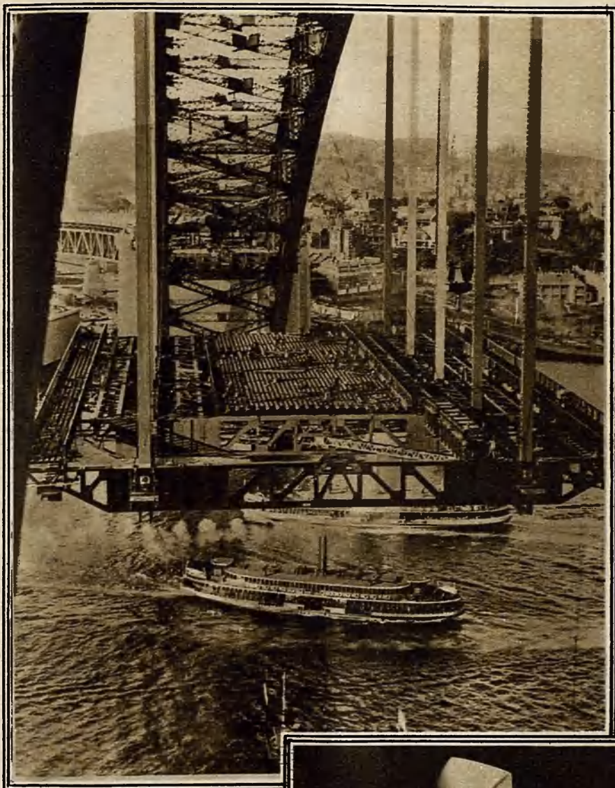
Imponente masa férrea y resuelto problema de ingeniería de que se enorgullecerá la bahía de Sydney, en Australia. Nótese que la construcción de la plataforma del puente se hace del centro a los pilares.
