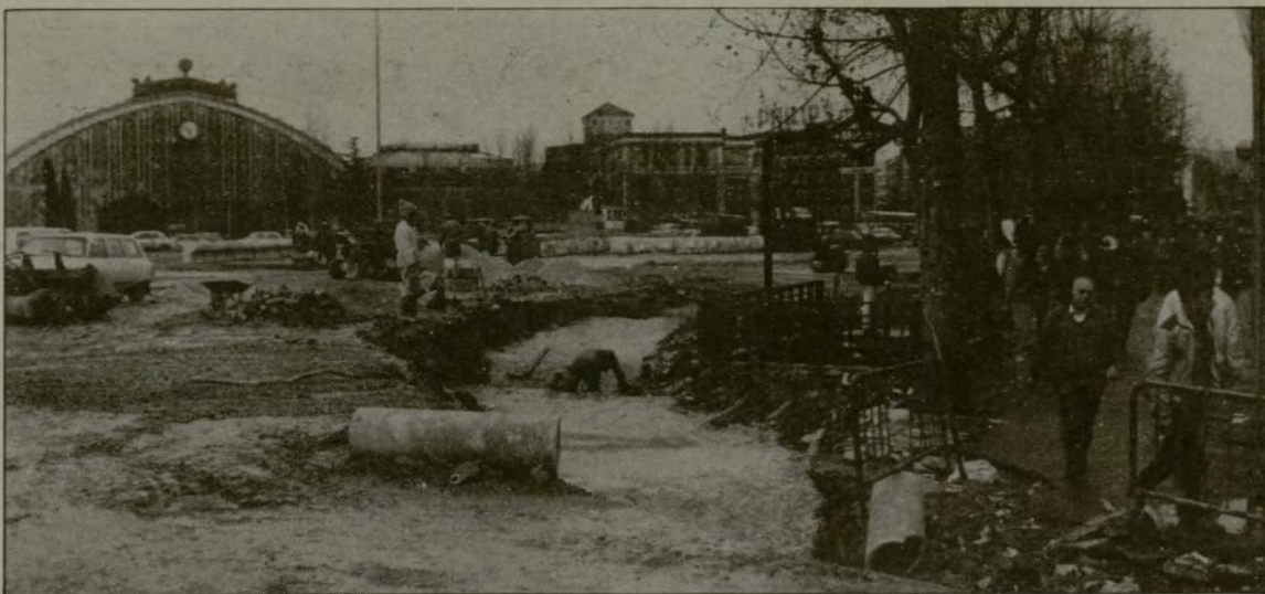
El asfalto de la glorieta se encuentra ahora en su última fase
