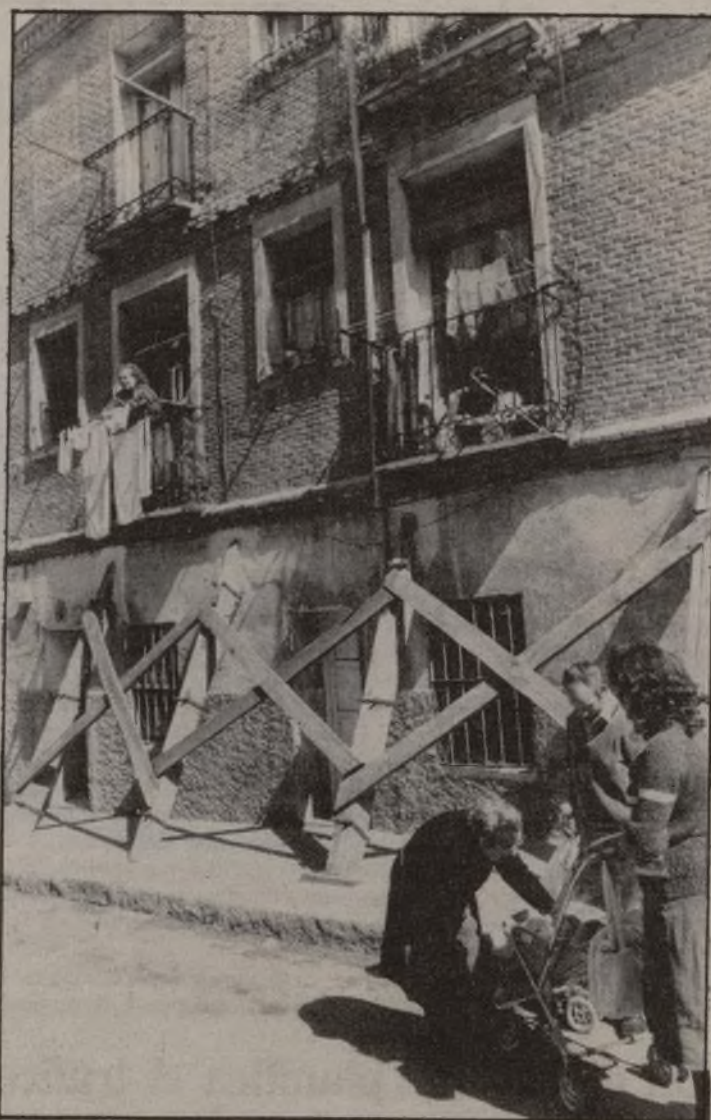
Los expedientes de ruina afectan a inmuebles de 19 distritos
