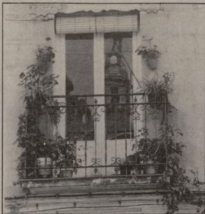
Los balcones alegran el edificio y el interior de la vivienda
