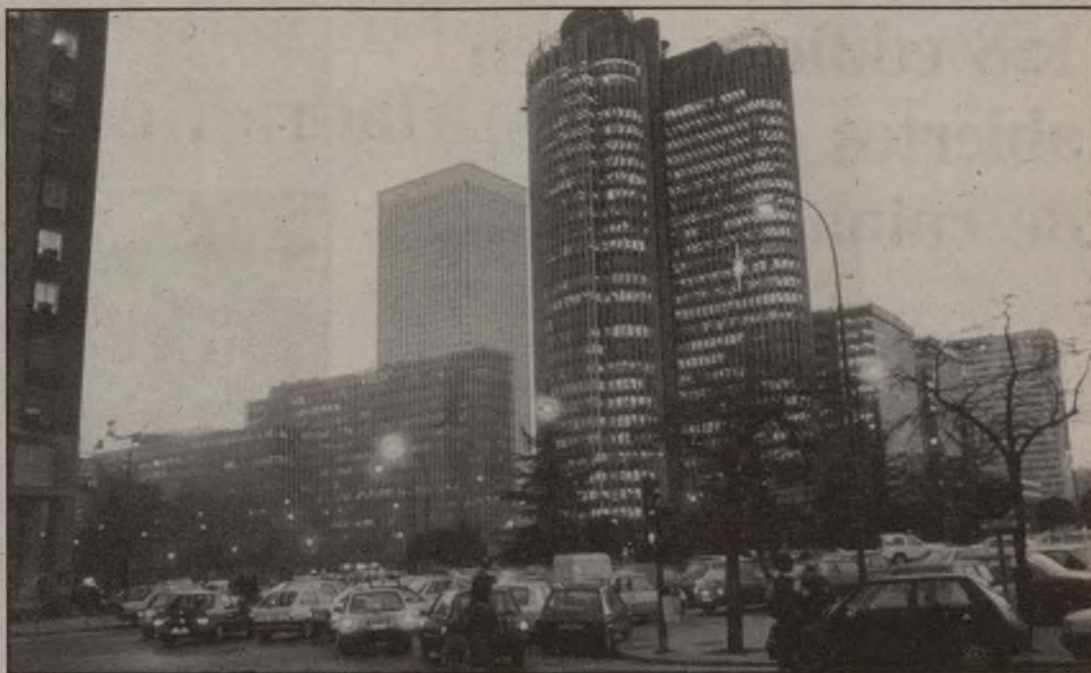
Las calles incluidas en la Red Estratégica Diferenciada forman los principales ejes de circulación
