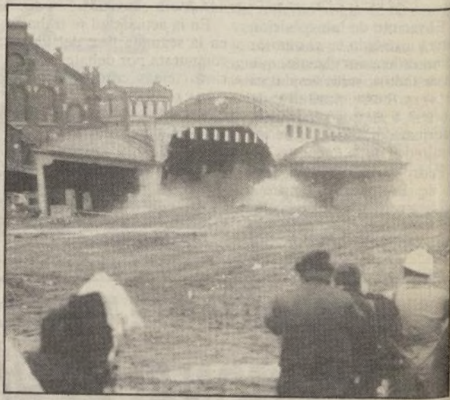
Voladura de la nave industrial de Méndez Alvaro
