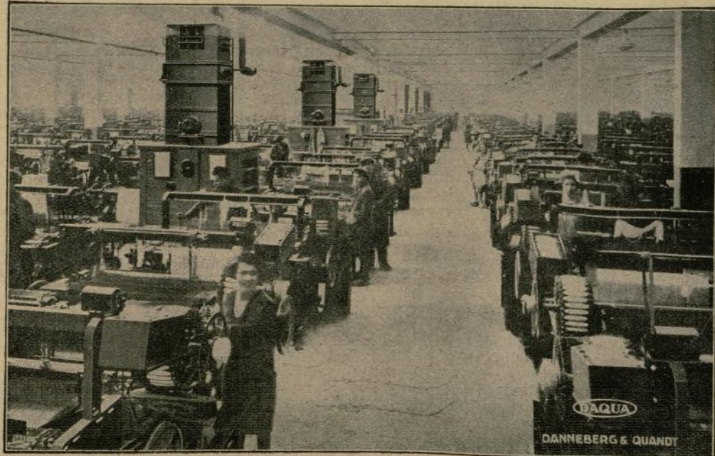
Instalación de humectación de aire del sistema DAQUA en combinación con calefacción de aire, ventilación y refrigeración.
