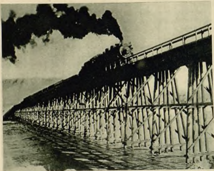
Presa Hoover, Arizona - El primer tren que cruza el famoso puente de doce kilómetros construido expresamente para unir los muelles de la gigantesca presa Hoover
