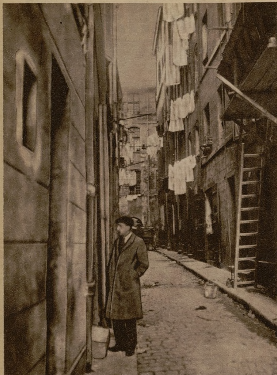
He aquí a nuestro compañero en otra calleja típica del barrio maldito. Una de tantas calles a las que los italianos del sur han traído su costumbre de colgar la ropa interior en cuerdas tendidas de ventana a ventana sobre la calle y sobre los propios transeúntes, que tienen que aguantar estoicamente el agua, que gotea sin ningún respeto.
