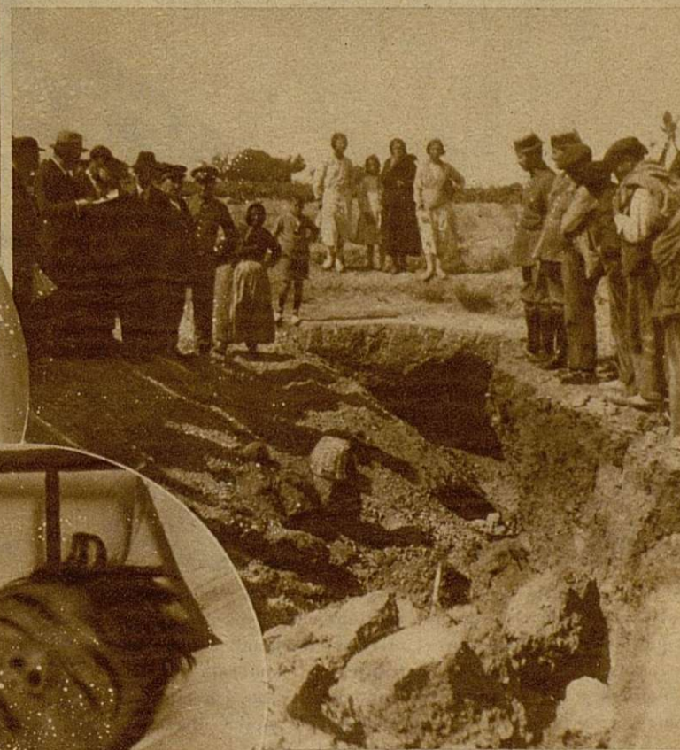
El Juzgado practicando diligencias en el lugar en que se produjo el desprendimiento de tierras y disponiendo el levantamiento del cadáver de Andrés de Pablo. Este obrero, según dictamen de los médicos, debió morir instantáneamente, por aplastamiento (Fotos Espinar)
