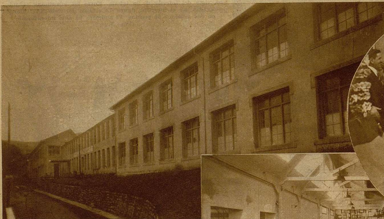
Vista de conjunto de la fábrica electrotécnica "Euzkaria", de G. Echevarría y Compañía, en Rentería, cuyos productos, después de expandirse por el mercado nacional, comienzan a conquistar los mercados extranjeros. Tiene esta fábrica 55 motores y 320 máquinas herramientas, y llega a laborar, entre otros productos, 600.000 tornillos y tuercas diarios
