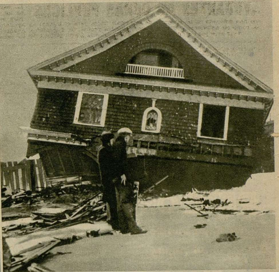
Estado en que quedó una casa próxima a la costa, derribada por la fuerza del huracán
