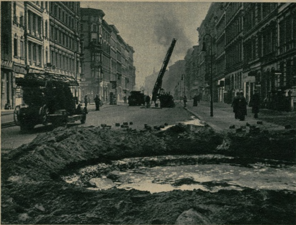
Boquete abierto en el pavimento de una calle de Berlín por una bomba de la supuesta aviación enemiga
