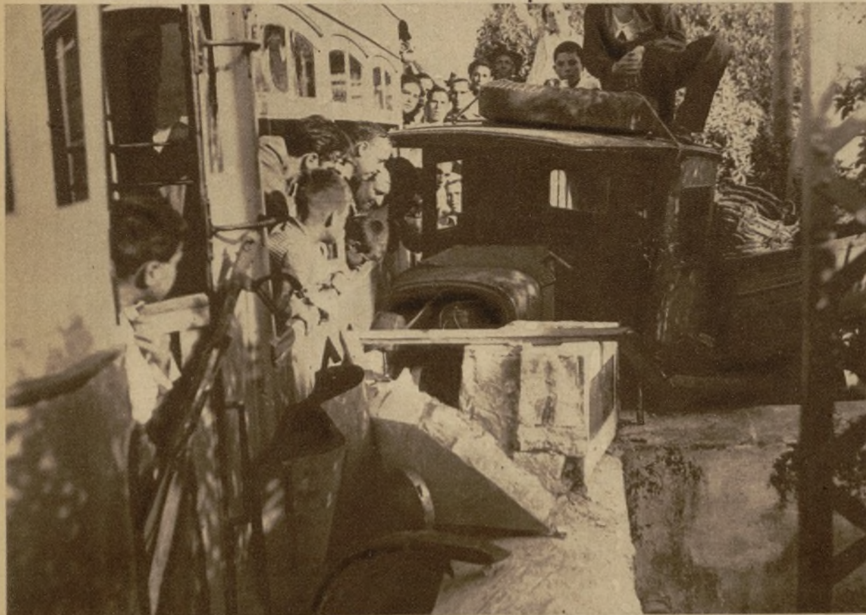
Estado en que quedaron un tranvía de la línea de San Fernando a Cádiz y un automóvil, que chocaron con enorme violencia, rompiendo el fuerte cantil de la carretera. En el accidente resultaron heridos el chofer y un pasajero del tranvía (Foto Dubois)
