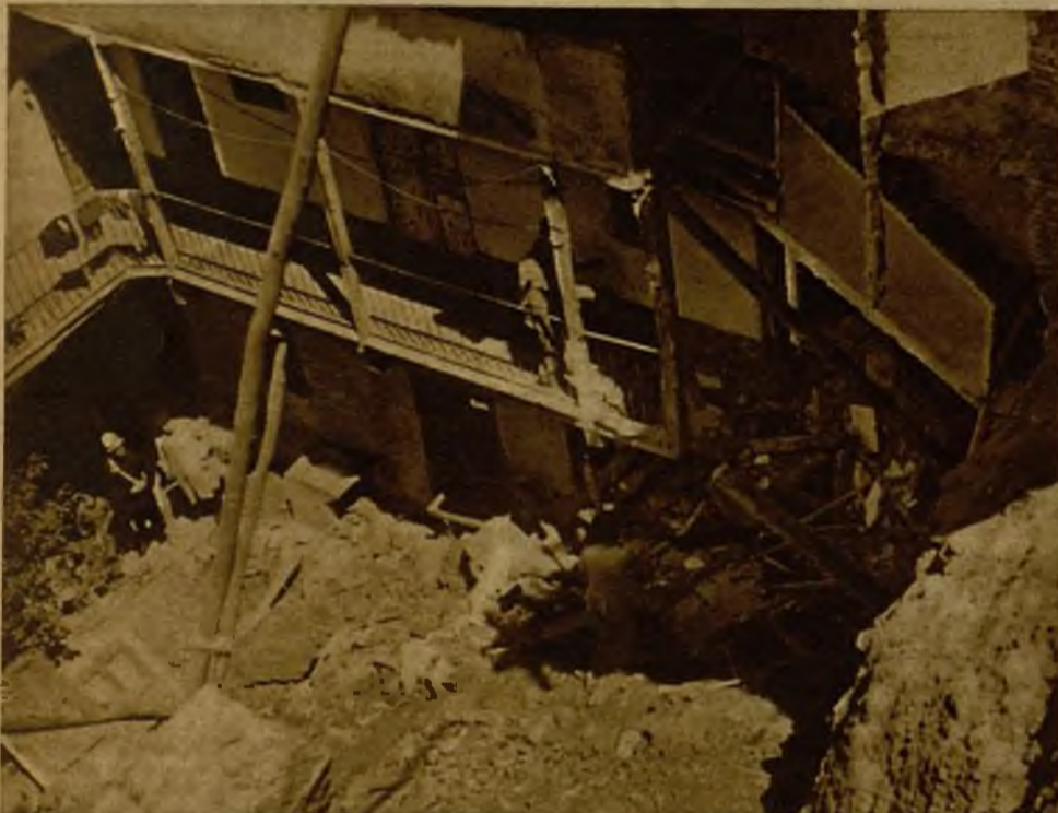
En Granada, a consecuencia de las pasadas lluvias, se hundieron las casas números 12 y 14 de la calle de Santa Ana, sin que afortunadamente ocurrieran desgracias personales. Numerosas familias modestas han quedado sin albergue
