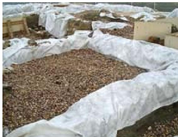
Detalle cubrición muros con geotextil y suelos con grava y zahorra
