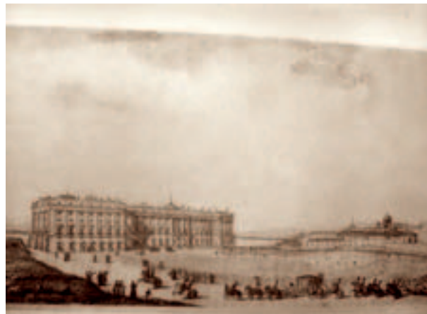
14. Vista del solar en que se urbanizará la Plaza de Oriente y su entorno como lugar de paseo.
