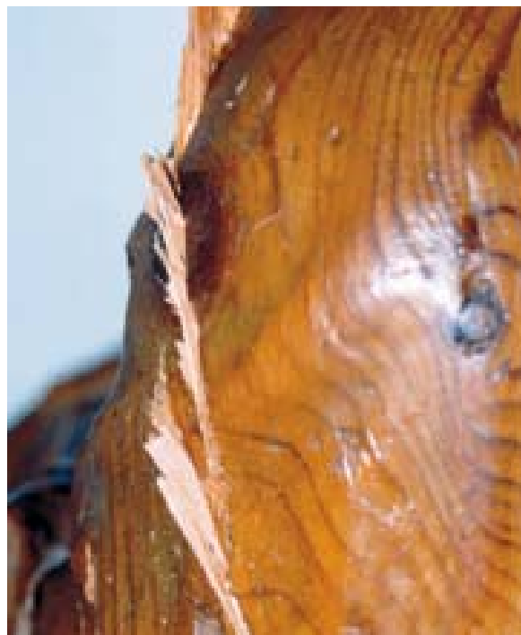
Reintegración con chapa de madera de conífera en las grietas
