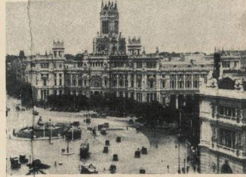
Palacio de Comunicaciones
