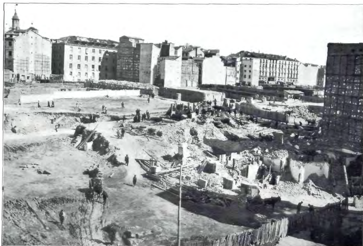
Travaux de démolitions de la place del Callao vus de la rue Preciados.
