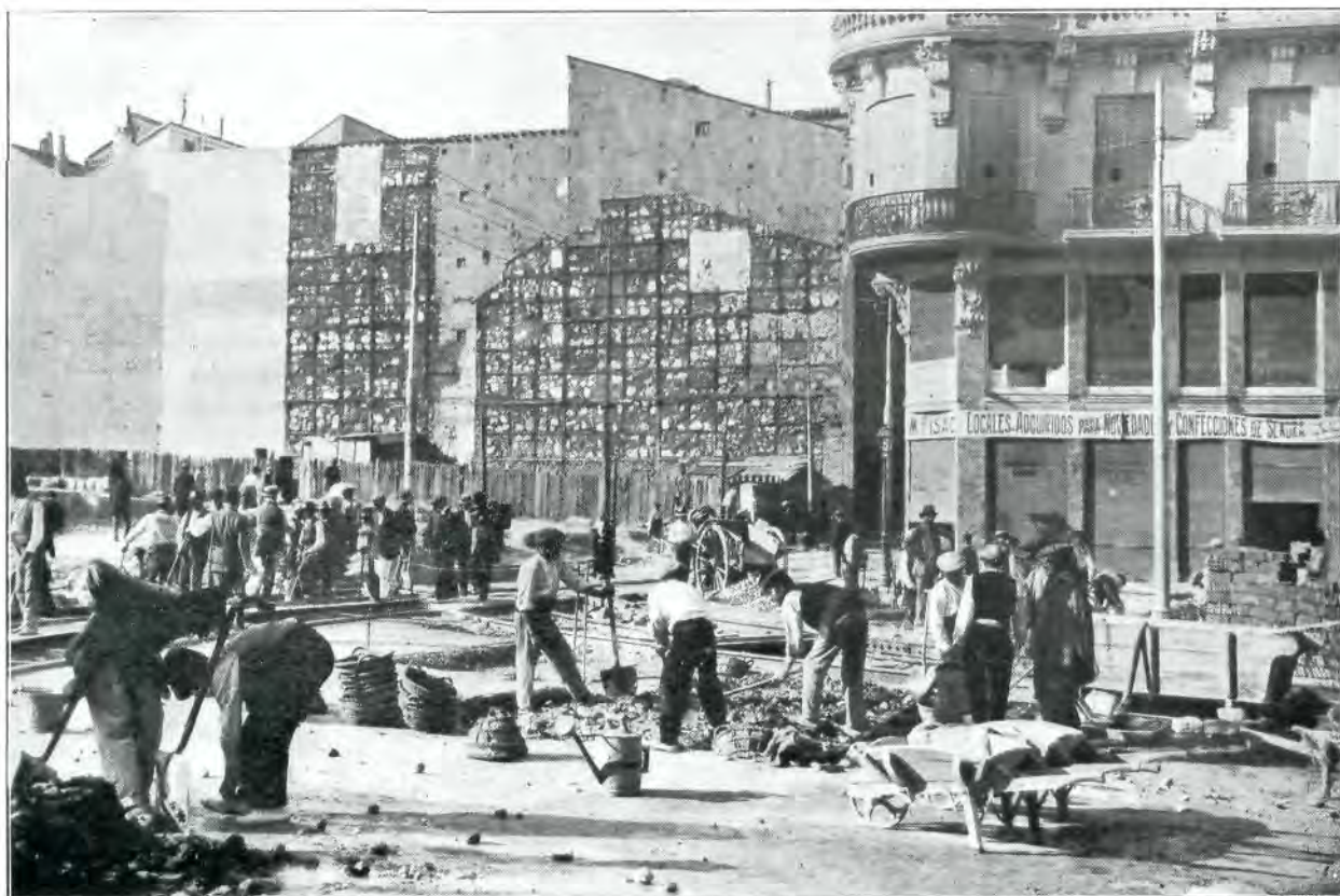
Achèvement de la première section de la Gran Vía. Carrefour San Luis.
