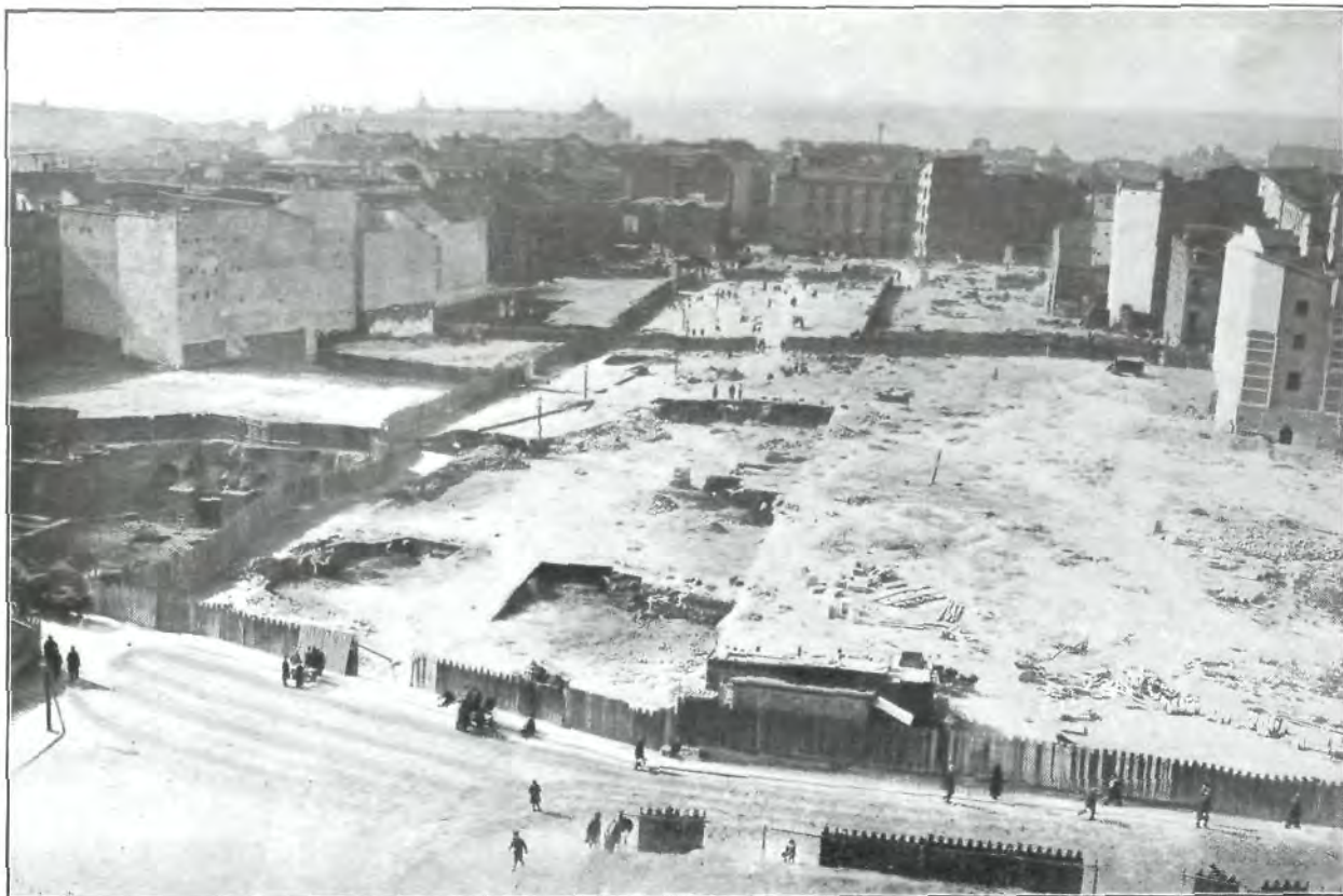
Perspective de la percée de la deuxième section vue du Carrefour San Luis.
