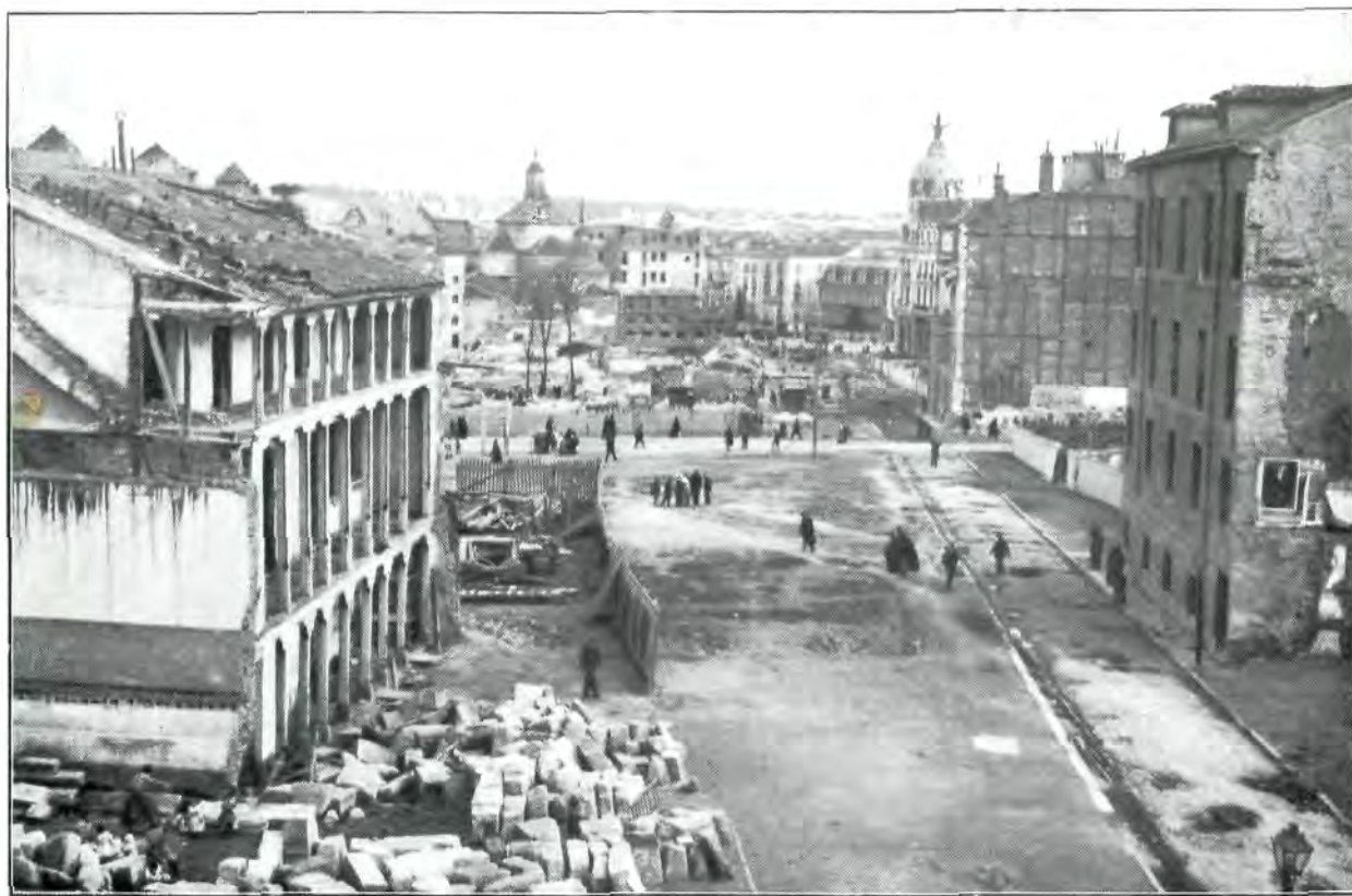
Démolitions du premier tronçon de la Gran Vía.
