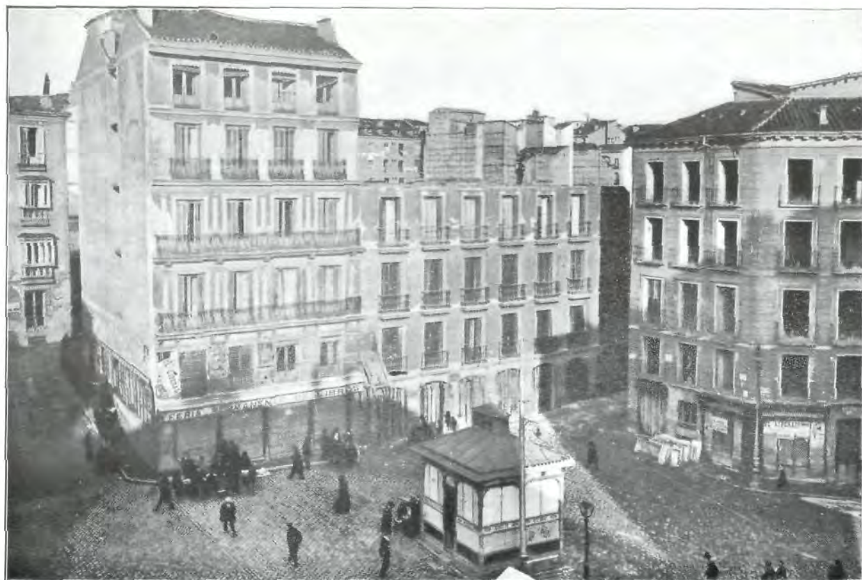
Vue de la Place del Callao avant la démolition.
