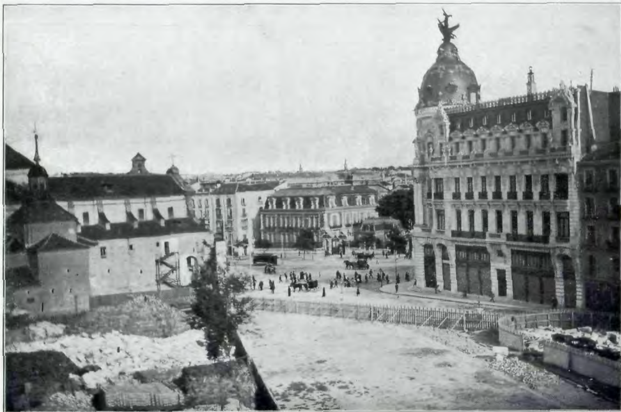
Vue des chantiers à l'entrée de la Gran Via.
