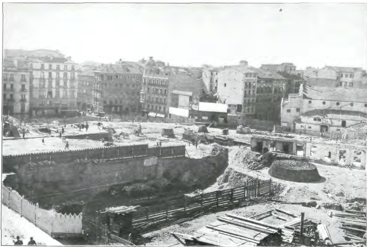
Aspect des travaux de la place del Callao vu de la rue Horno de la Mata.
