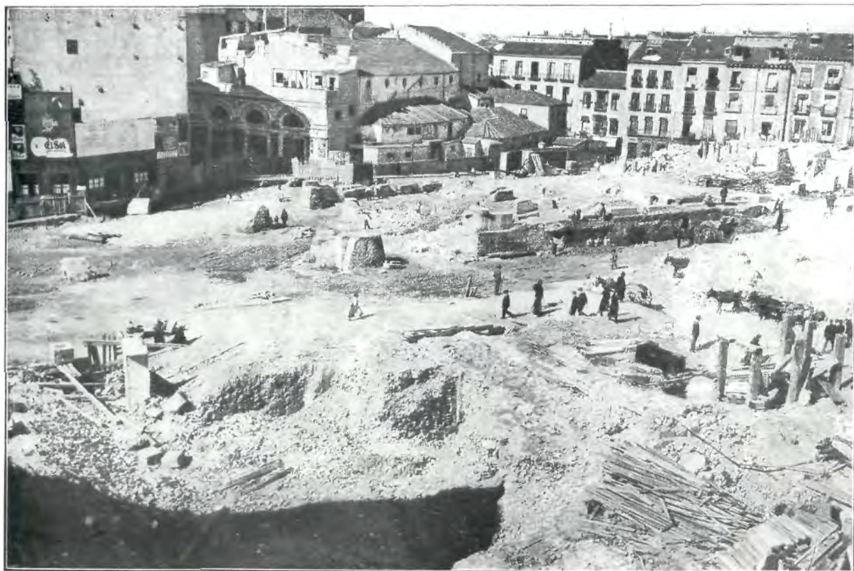
Achèvement des travaux de démolition de la place del Callao.
