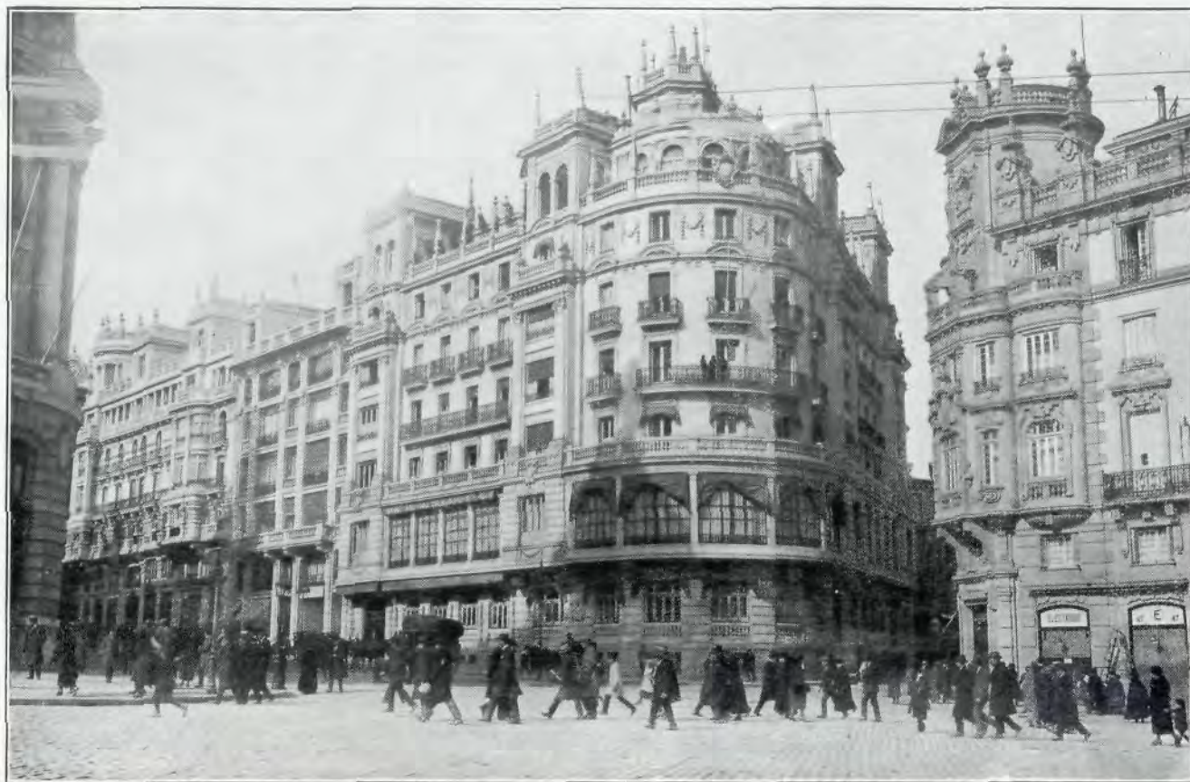
Nouveaux immeubles à l'entrée de la Gran Vía. Le Cercle de la Gran Peña.
