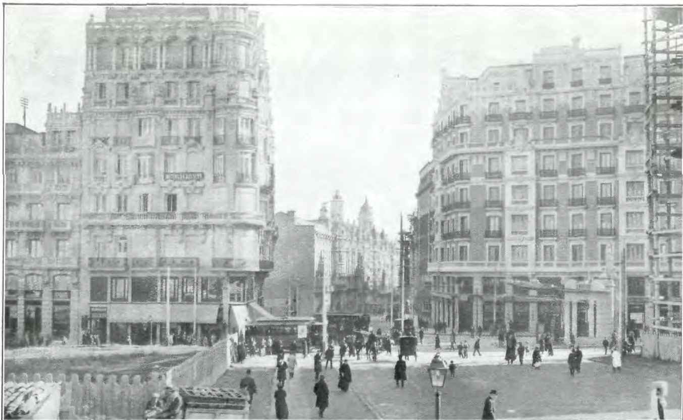
Carrefour San Luis vu de la deuxième Section. A droite station du Métro.
