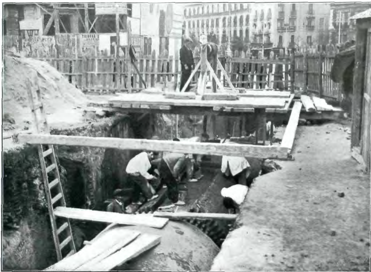
Raccordement de l'égout avec le collecteur d'Alcalá.
