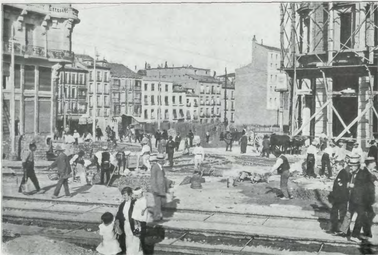
Carrefour San Luis. — Pose des rails de tramways.
