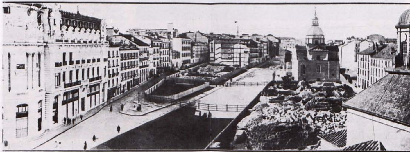
Vista panorámica del terreno que ha de ocupar el primer trozo de la Gran Vía y estado actual de las obras de demolición, en su aspecto desde la calle de Alcalá
