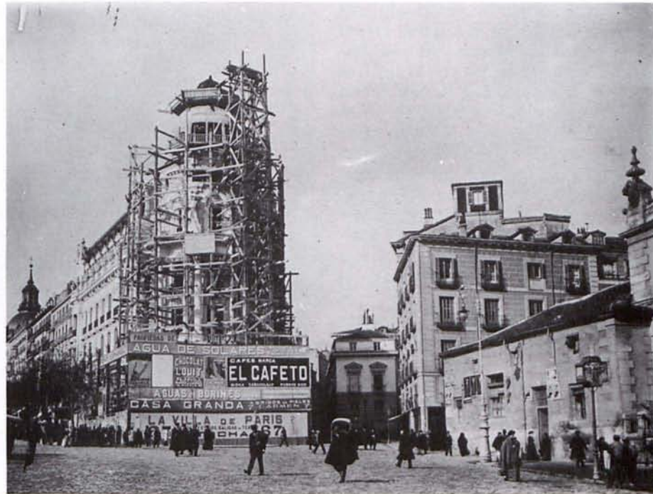
El edificio de «La Unión y El Fénix», durante su construcción. Aún no habían comenzado las obras de la Gran Vía.
