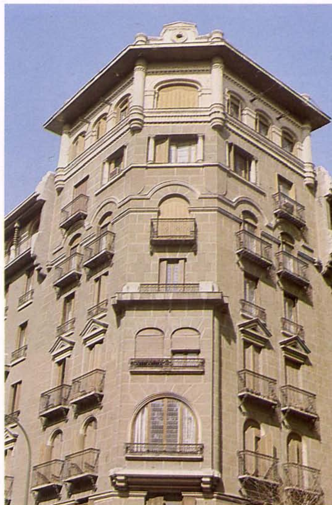
Edificio de viviendas en la calle de Alberto Aguilera, con vuelta a la de Guzmán el Bueno.
