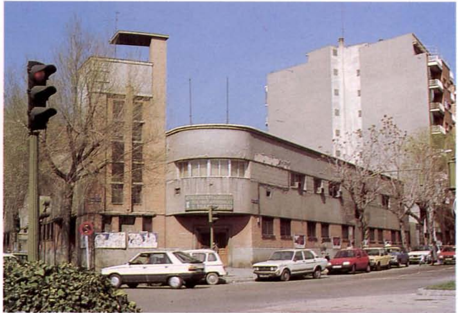
Talleres Generales del Ayuntamiento de Madrid, en el Paseo de la Chopera.
