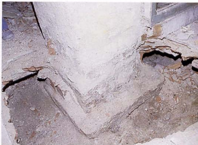
Pilastra del sótano.
