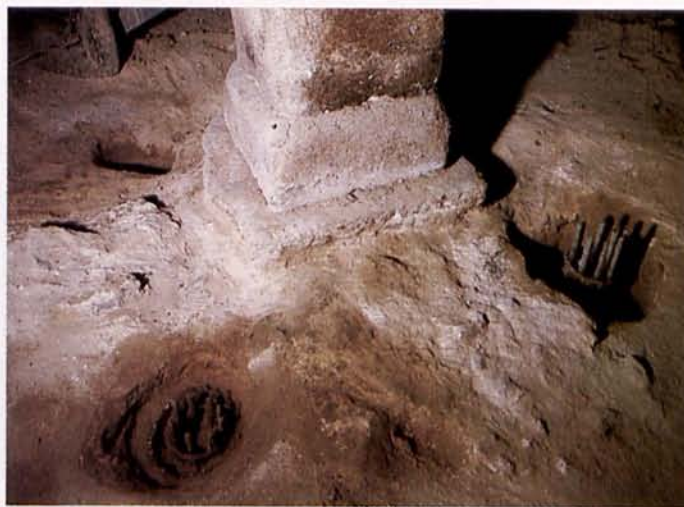
Solución constructiva del recalce.
