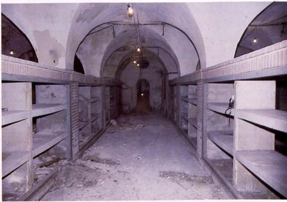
La planta de sótano, antes de las obras.
