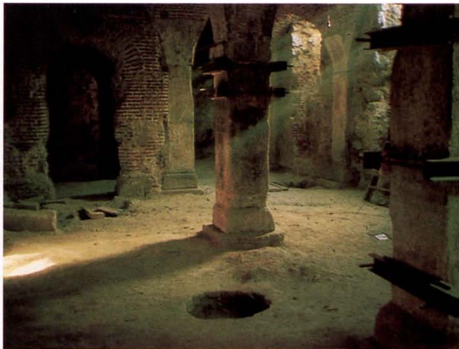
Vista general del sótano.
