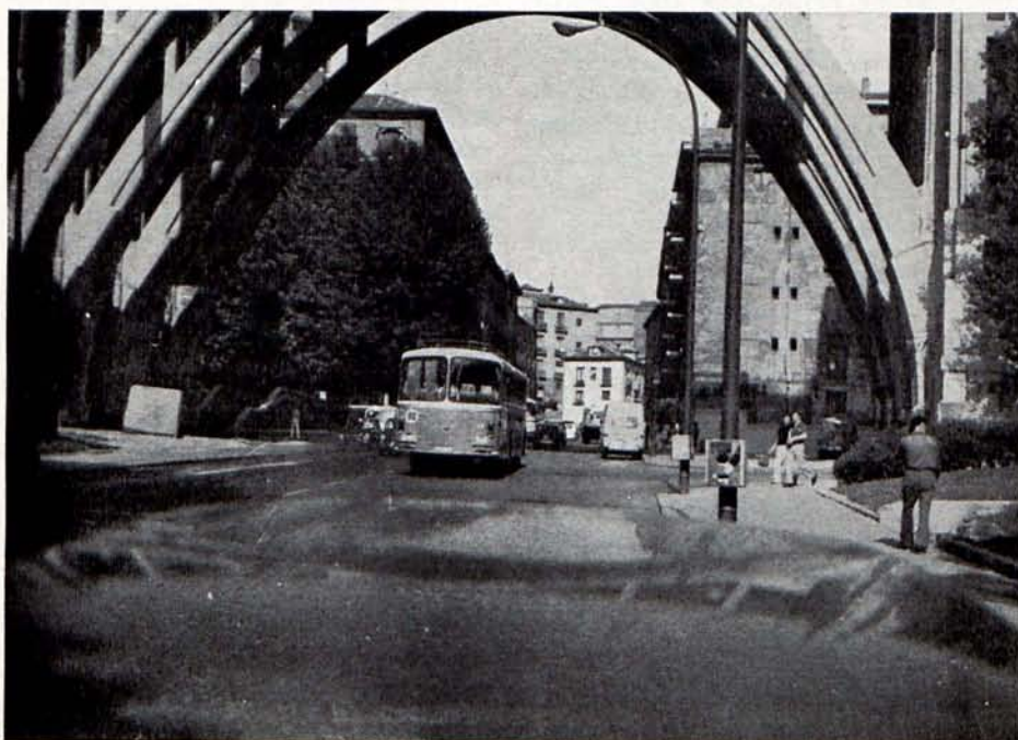
La calle de Segovia es uno de los viejos caminos de la villa que se ha consolidado como importante vía de penetración. Aquí la vemos bajo el Viaducto, donde ya empieza a estrecharse y retorcerse para acabar en Puerta Cerrada.
