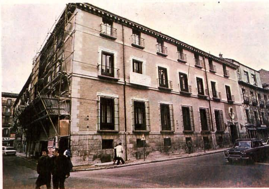
Palacio de los Baver. La fachada, una vez libre de los revocos que la cubrían, ha recobrado su estampo clásica, con la feliz combinación del ladrillo y la piedra
