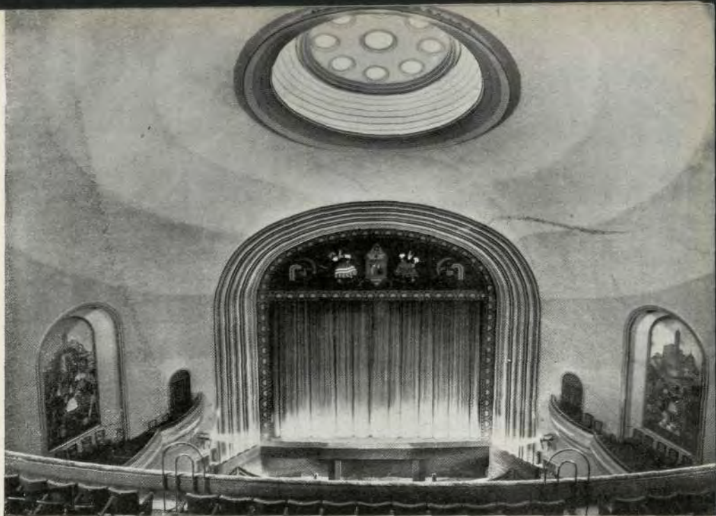
La embocadura y lucernario vistos desde el principal.
