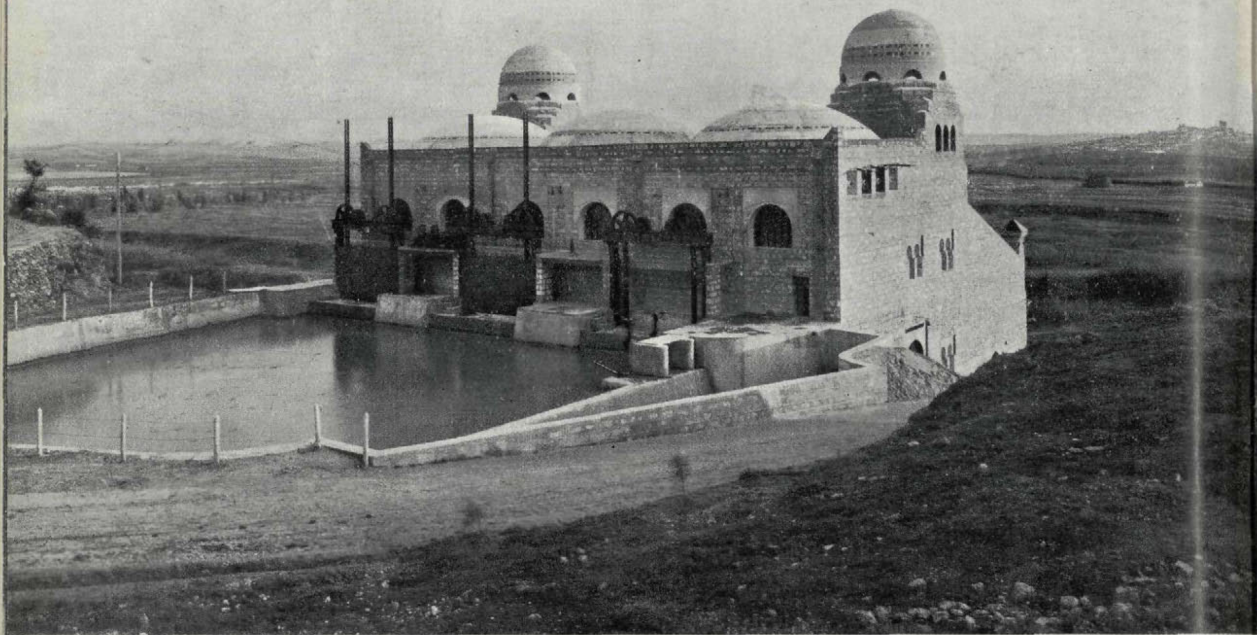
La Central. Fachada posterior. Al fondo, el pueblo del Carpio.
