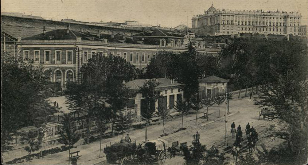
MADRID: ESTACIÓN DEL NORTE.
