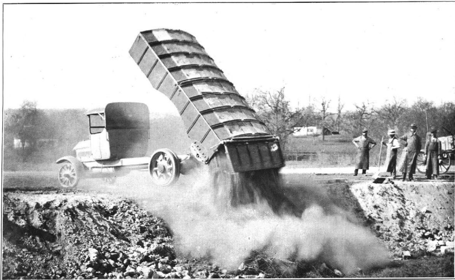
Descarga automática del camión automóvil.
