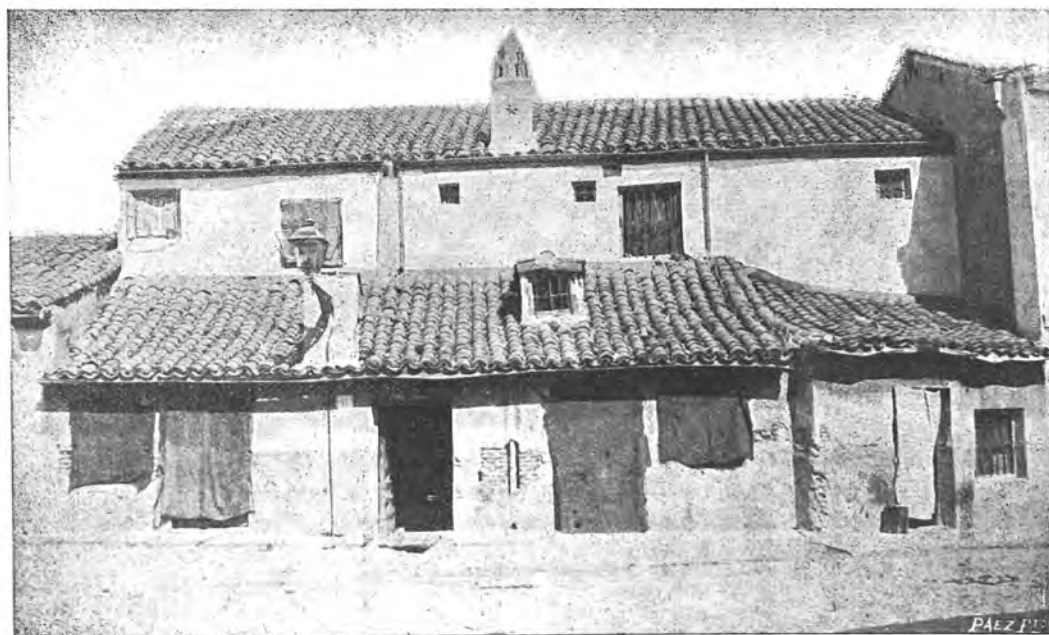
Calle de las Peñuelas.—Casa núm. 15.— Distrito de la Inclusa, barrio de las Peñuelas. Mortalidad del barrio: 47'53 por 1.000.
