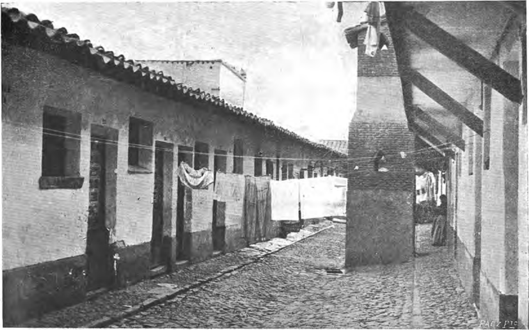
Callejón del Alamillo.—Interior de la casa núm. 5.
