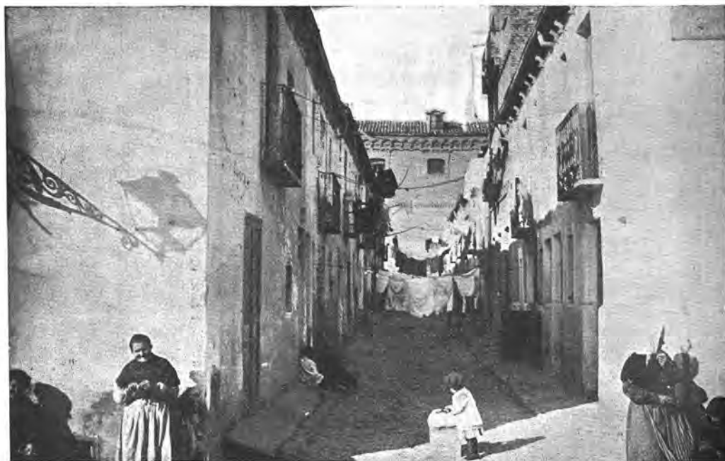
Callejón del Ferrocarril.—Distrito del Hospital, barrio de Santa María de la Cabeza. Mortalidad del barrio: 37'85 por 1.000.
