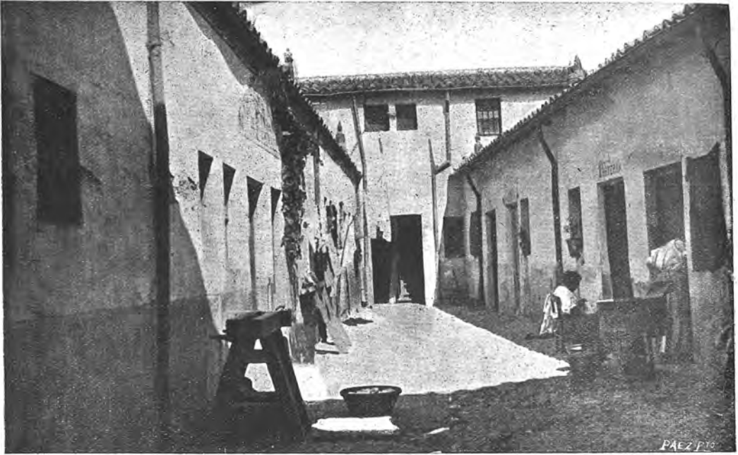
Calle de las Peñuelas.—Interior de la casa núm. 21.
