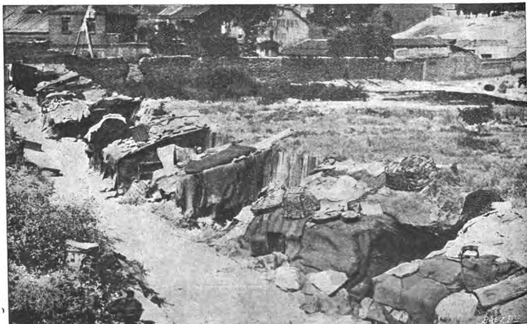
Chozas existentes en el arroyo de Embajadores.
