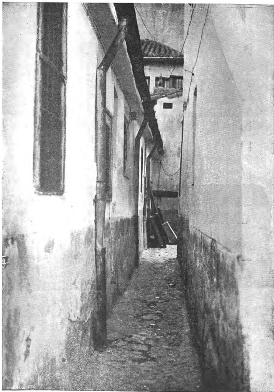
Casa Cuartelillo de la plaza de Lavapiés.—Un patio lateral.
