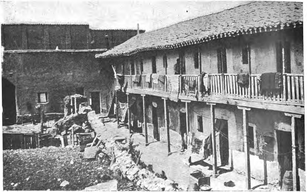
Calle de la Verdad.—Interior de la casa núm. 13.
