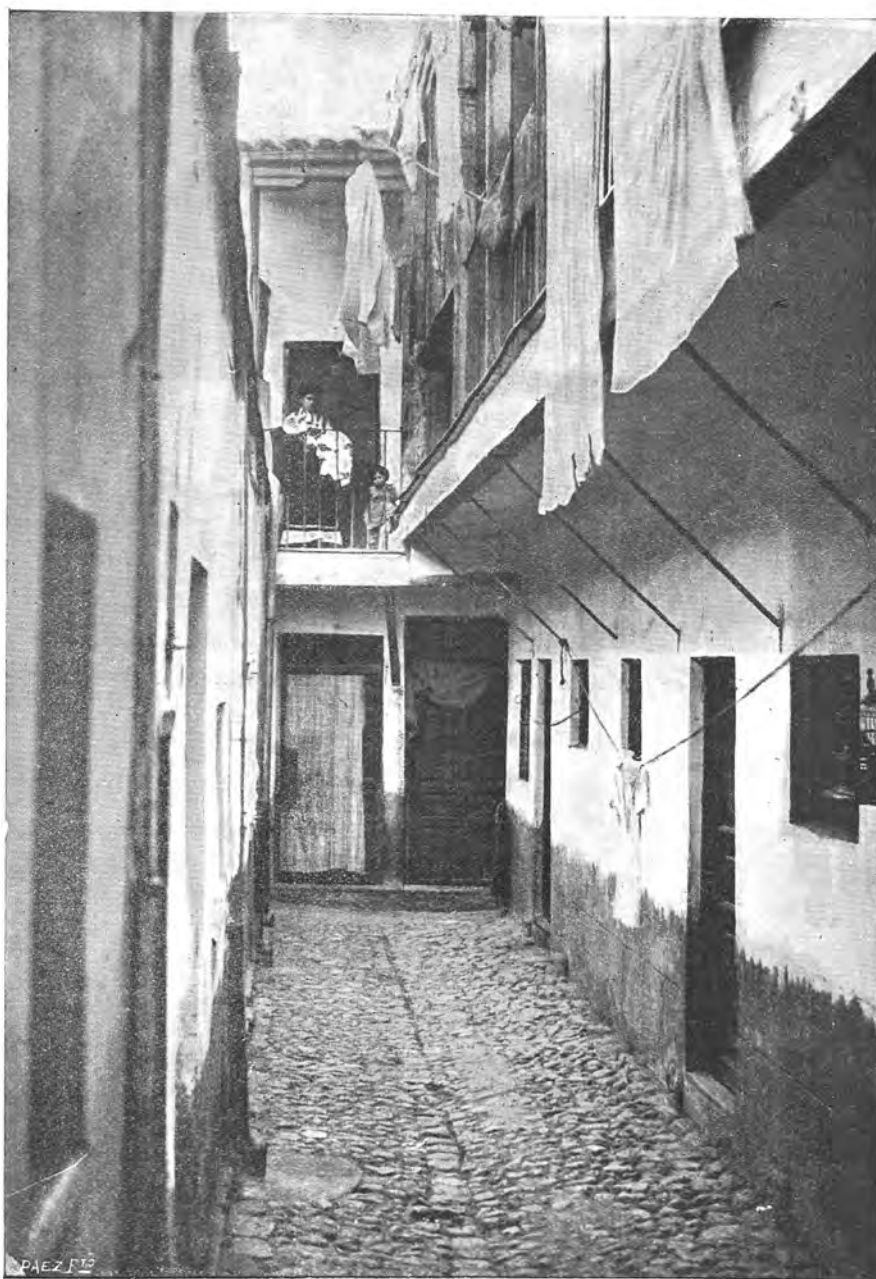
Calle de las Peñuelas.—Interior de la casa núm. 18.
