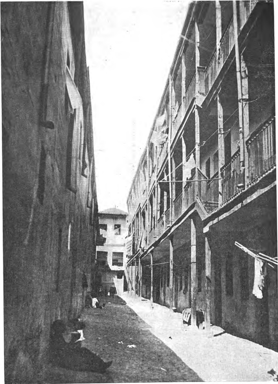
Ronda de Toledo.—Interior de la casa núm 14.—Distrito de la Inclusa, barrio de Amazonas.—Mortalidad del barrio. 37·79 por 1.000.
