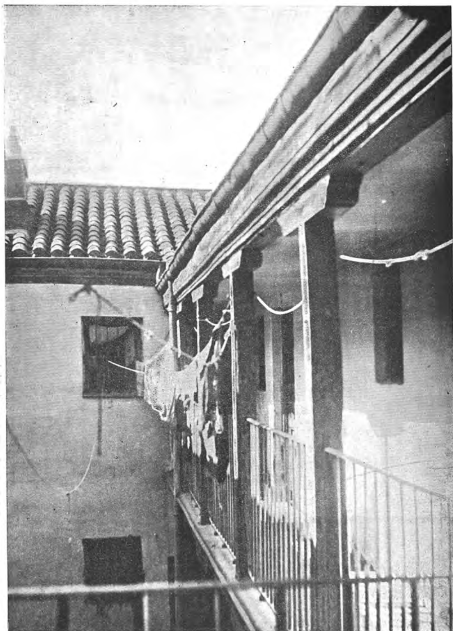
Calle del Salitre.—Galería de la casa núm. 36.—Distrito del Hospital, barrio de Primavera.—Mortalidad del barrio: 42'31 por 1.000.
