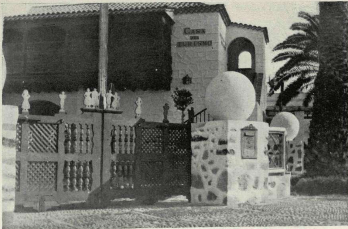
Detalle de la cancela de cerramiento.
