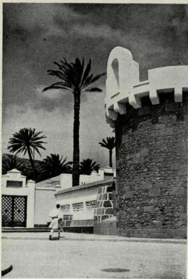
Uno de los torreones de la portada de ingreso.
