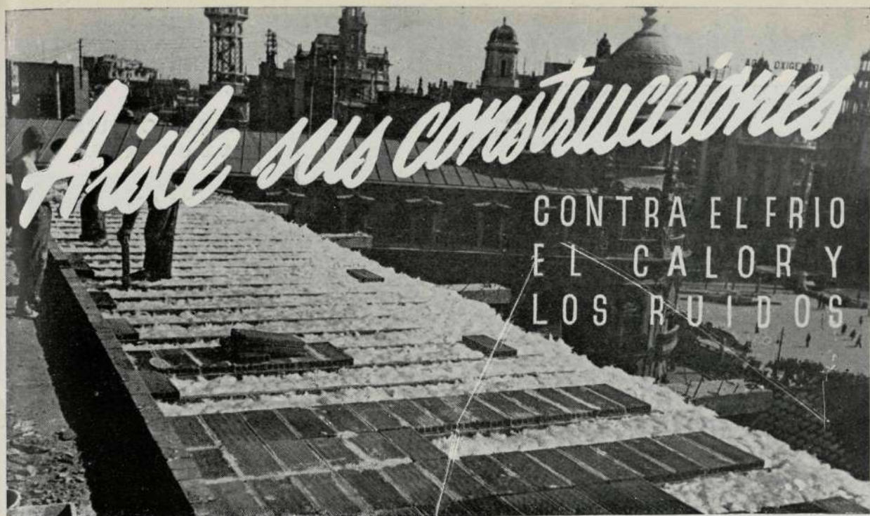
Aislamiento térmico de terrazas en un edificio en construcción. Valencia. Arquitecto: Don Joaquín Rieta.
