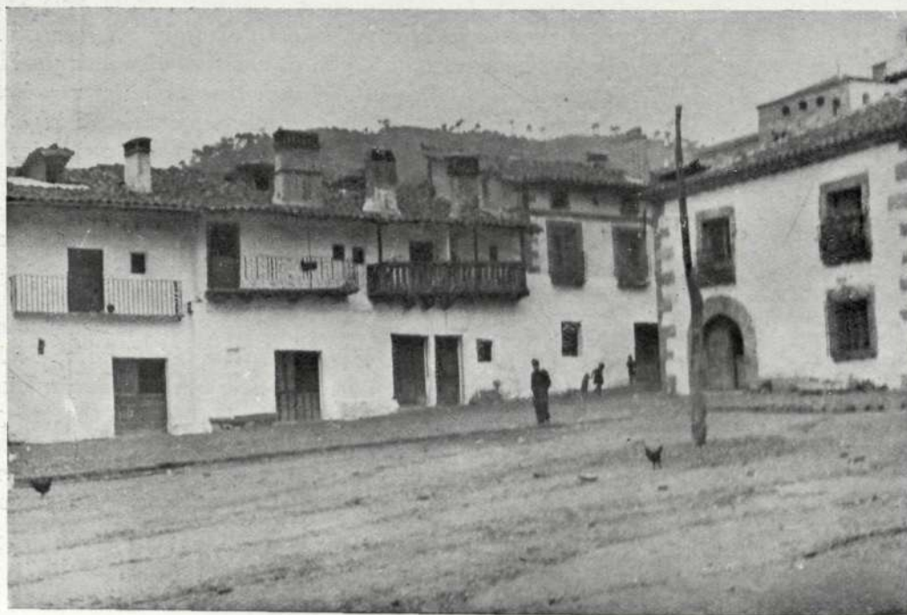
Desde los balcones de madera, volados, de la plaza...
