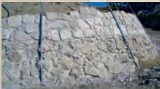
Contraste entre el aparejo original y el nuevo en la restitución de una de las torres de la barrera
