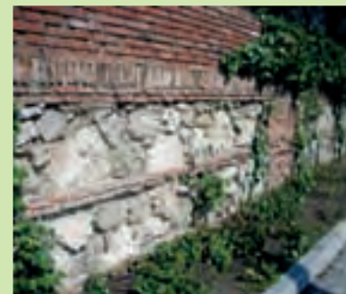
Tapia de El Capricho, con las piezas de sílex a la vista
