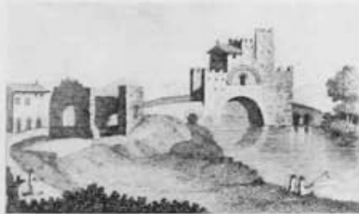
VEDUTA DEL PONTE LAMENTANO
