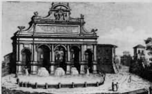
VEDUTA DEL FONTANONE DI S. P.º MONTORIO.
