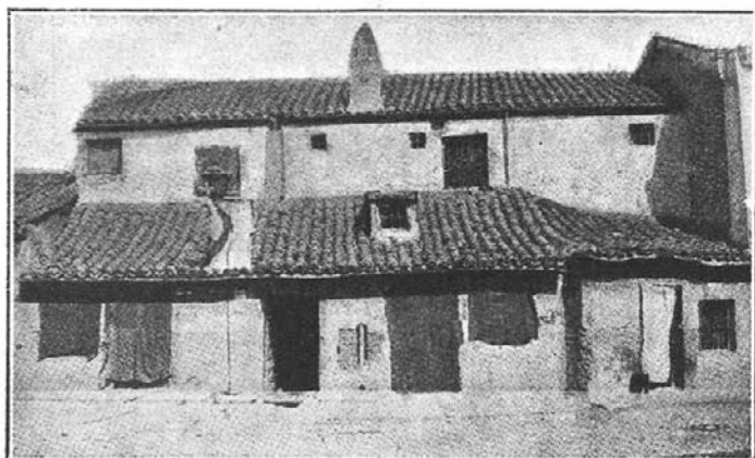
Calle de las Peñuelas, casa núm. 15. — Distrito de la Inclusa, barrio de las Peñuelas.
