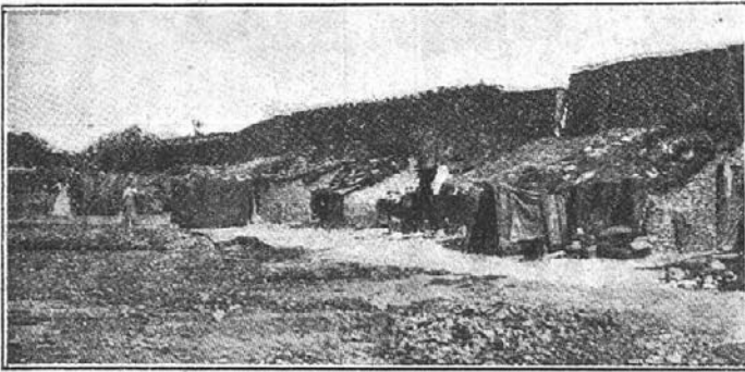
Grupo de chozas que existían a primeros de julio de 1925 en la calle de Magallanes, 19, solar. — Distrito de la Universidad, barrio de Lozoya.
