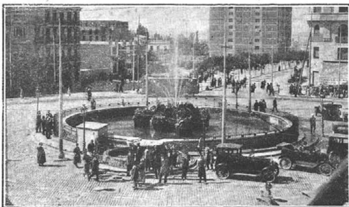
Descargador sistema E. Ortega construido en la glorieta de Ruiz Giménez, Cuatro Caminos, Madrid. Utilizase para la carga (nueve metros cúbicos) el sobrante de la fuente. Descarga 1.600 litros por minuto. Los buzones destapados corresponden al acumulador y al pozo de comunicación con la alcantarilla, cuya limpieza automática efectúa.
