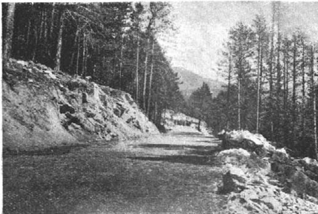
La explanación antes del asiento de la vía.
