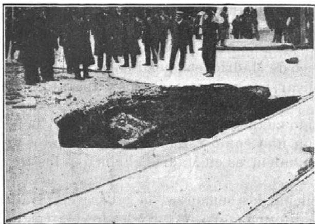
Vista del aspecto superficial en los primeros momentos del hundimiento que en la plaza de Oriente, ante la puerta del Príncipe, se produjo al paso de un tranvía el 17 de marzo de 1910. Realidad del hundimiento: profundidad, 24 metros; longitud, 60, y latitud, 15. (Encargado de la reparación E. Ortega.)
