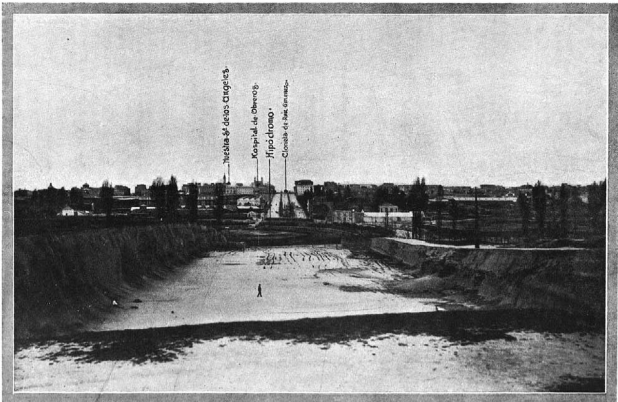
Paseo de Ronda, explanación
