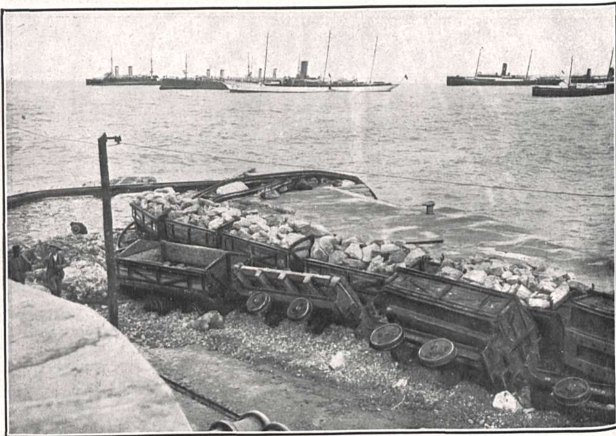
Efectos causados por las olas en las obras del puerto de Melilla. Trozo de la vía férrea destruido
