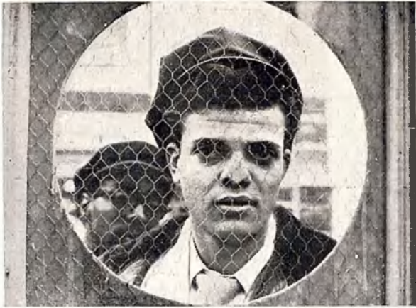
Con la nariz aplastada contra el cristal, como un chico de la escuela, este neoyorquino mira las obras de la calle Broadway.
