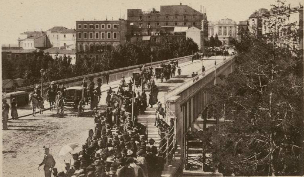
44. MADRID.—Viaducto sobre la calle de Segovia.
