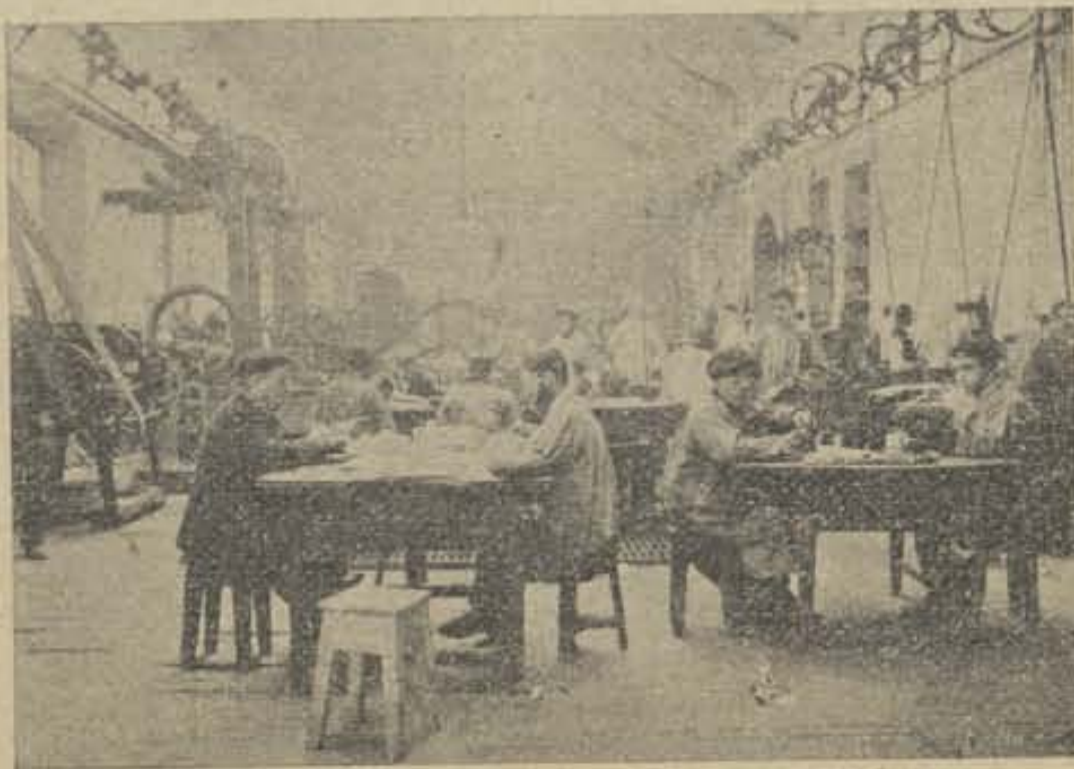
Talleres de construcción.
