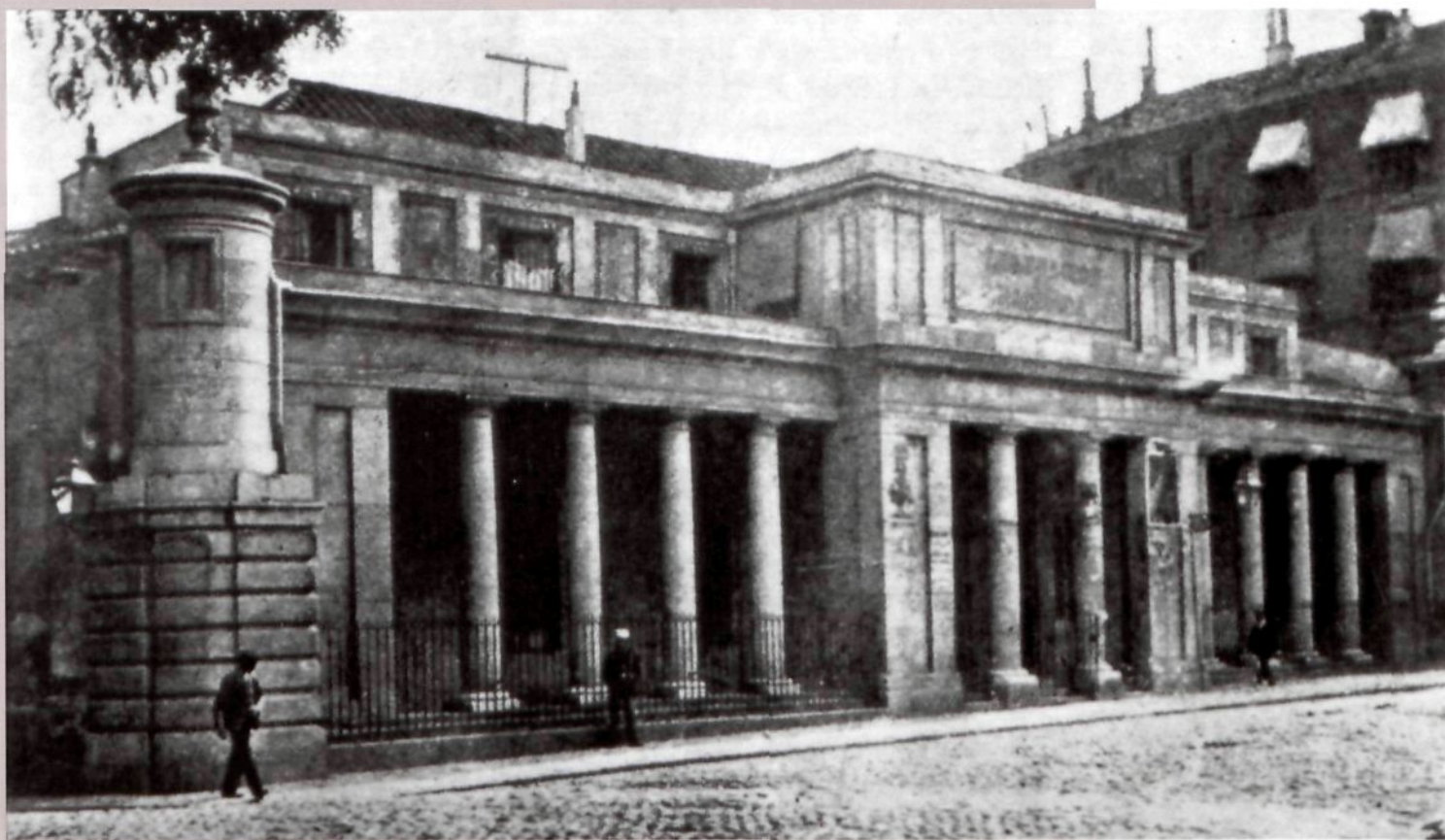
Real Fábrica de la Platería de Martínez. Antes de su derribo.
