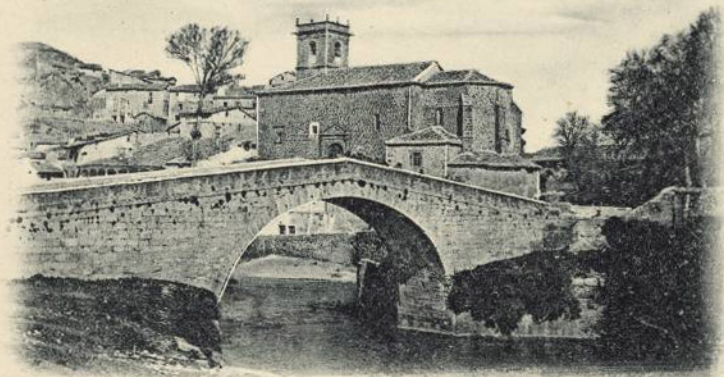
Puente de Trillo sobre el Tajo
