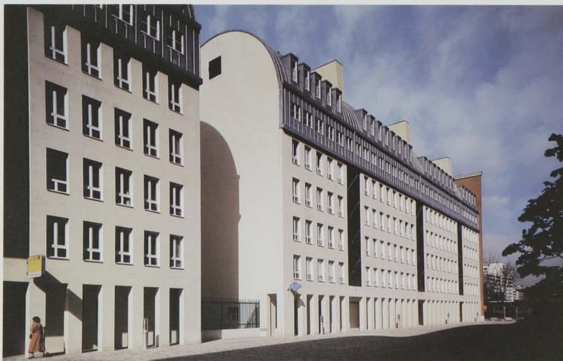
DE LA "RECUPERACIÓN DE LA DISCIPLINA": Edificio de Viviendas sociales, de Aldo Rossi, 1991.
