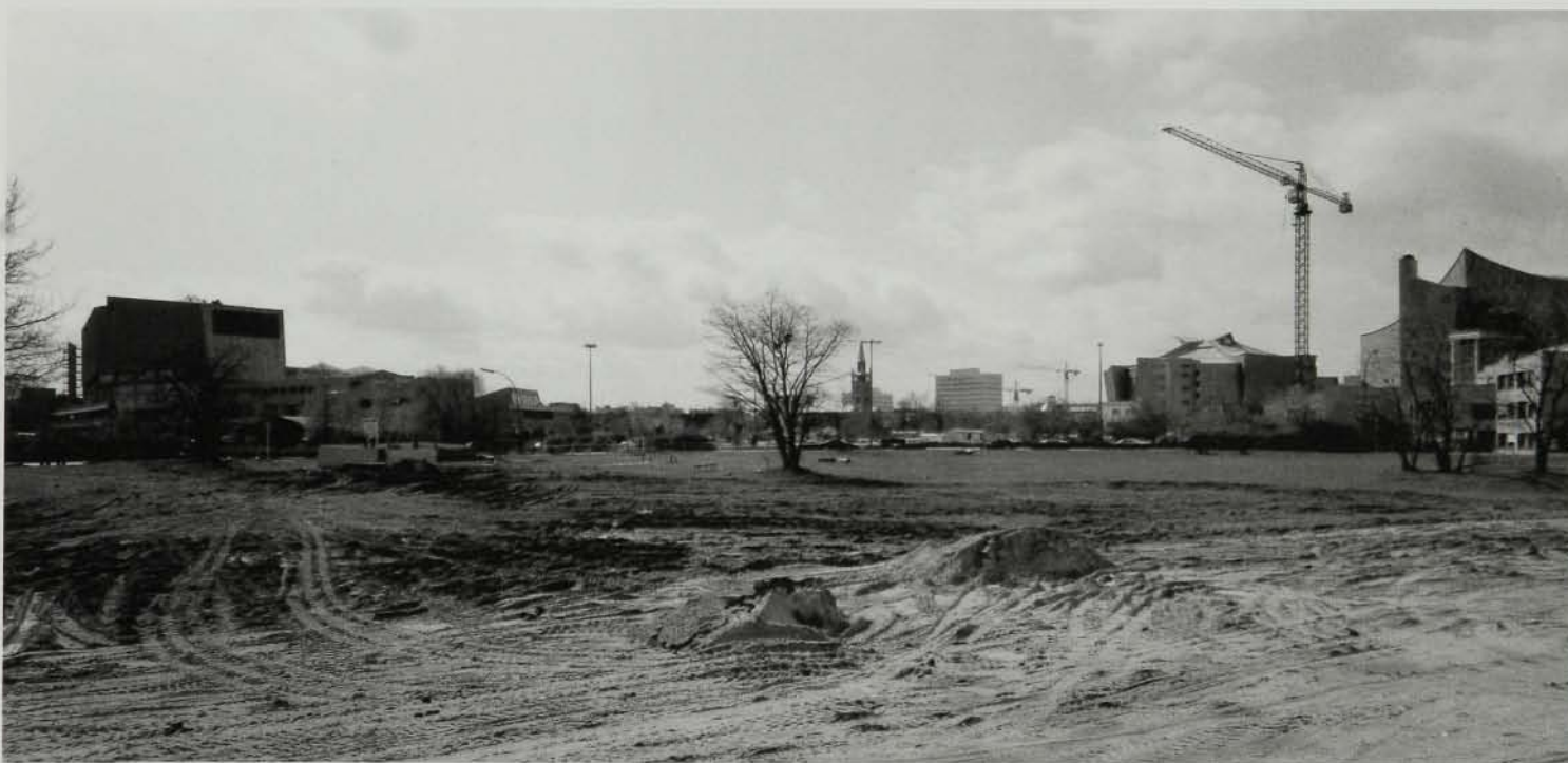
DOS IDEAS CONTRARIAS DE ARQUITECTURA ALEMANA Y OTRAS ARQUITECTURAS CULTURALES: El Kulturforum desde las áreas vacías por la destrucción del muro. De izquierda a derecha, la Biblioteca del Estado (1978), la Sala de Música de Cámara (1987) y la Filarmónica (1963), de H. Scharoun.
