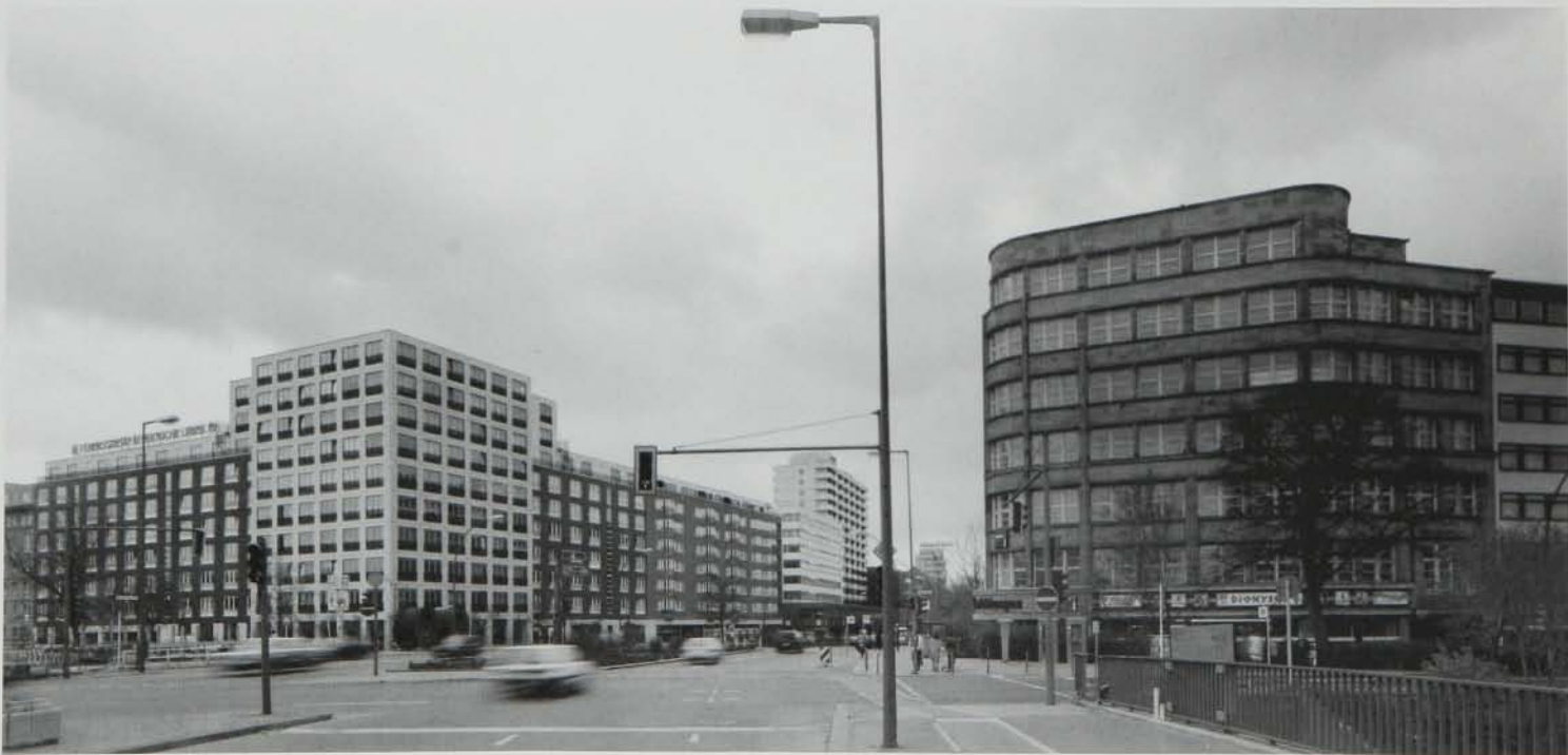
LA RECUPERACIÓN DE LA ARQUITECTURA URBANA EN EL IGNORADO FINAL DE LA CIUDAD DIVIDIDA: EL I.B.A. (1980-1987). Actuación del I.B.A. contigua al Kulturforum. Obras de los arquitectos Sawade y Heinrichs & Partner.
