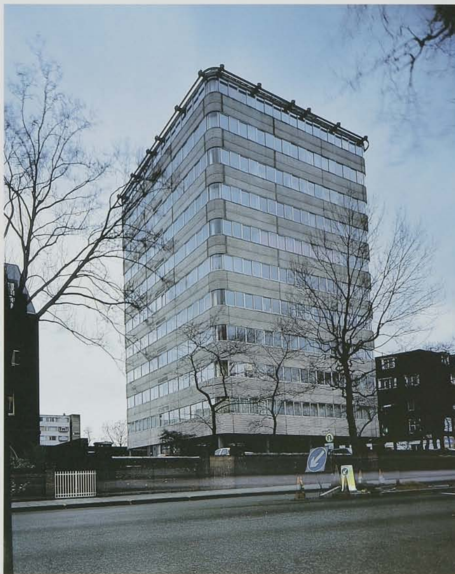
SE INICIÓ EL RADICALISMO MODERNO EN REGENT'S PARK: Torre de viviendas de Farrell y Grimshaw, 1970.
