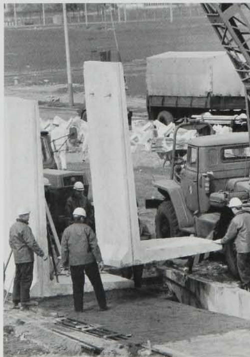
EL CERCO A OCCIDENTE: Nuevo Muro entre Potsdamer Platz y Brandenburger Tor, 1976.
