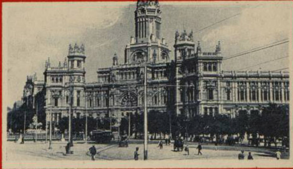
MADRID - Palacio de Comunicaciones
