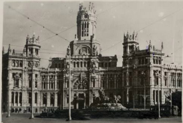
Madrid, 29 Palacio de Comunicaciones
