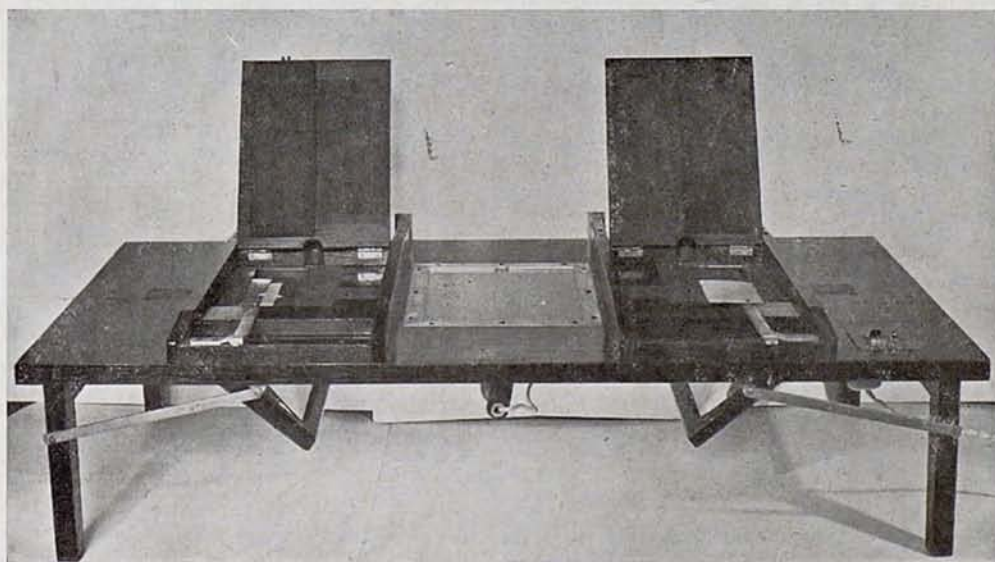
Fig. 6.—Aparato de fotografía estereoscópica que permite la obtención de estereogramas en placas diapositivas, para la observación por transparencia.
