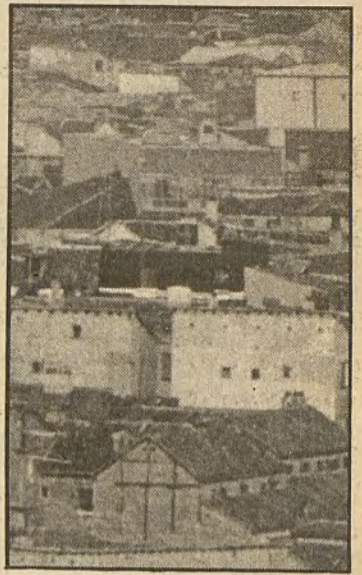
Conservar lo que existe, pero rehabilitar los deterioros
