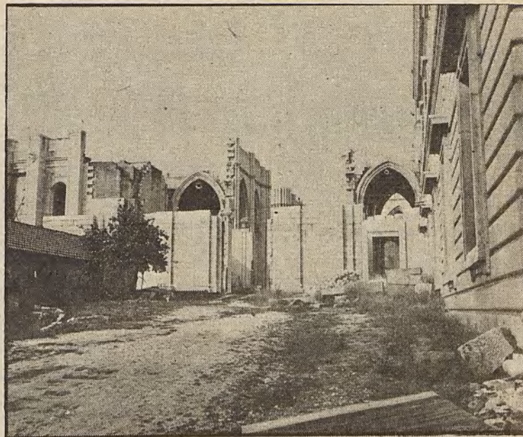
La primitiva iglesia de la Almudena se instaló en la antigua Mezquita mayor de Madrid, de pequeña y mezquina arquitectura. Fue demolida en el s. XIX. En la foto, obras sin acabar de la nueva iglesia
