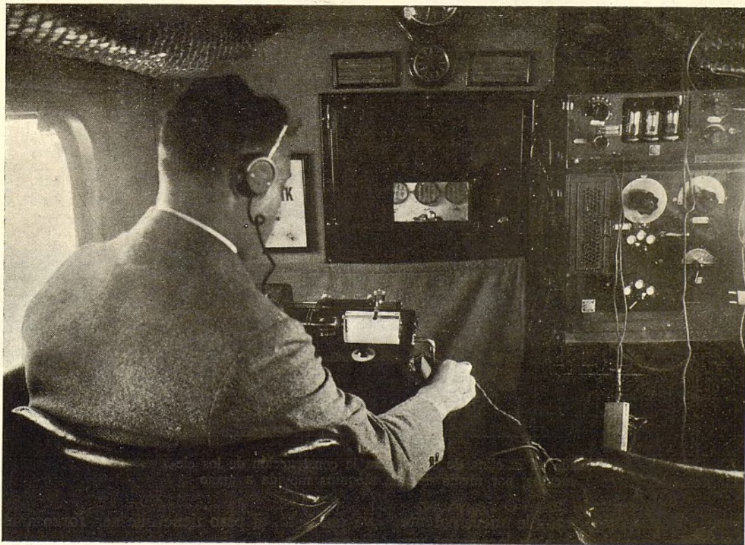
El aparato receptor Fultograph , para recibir mapas meteorológicos, planos de campos, etc., por radio
