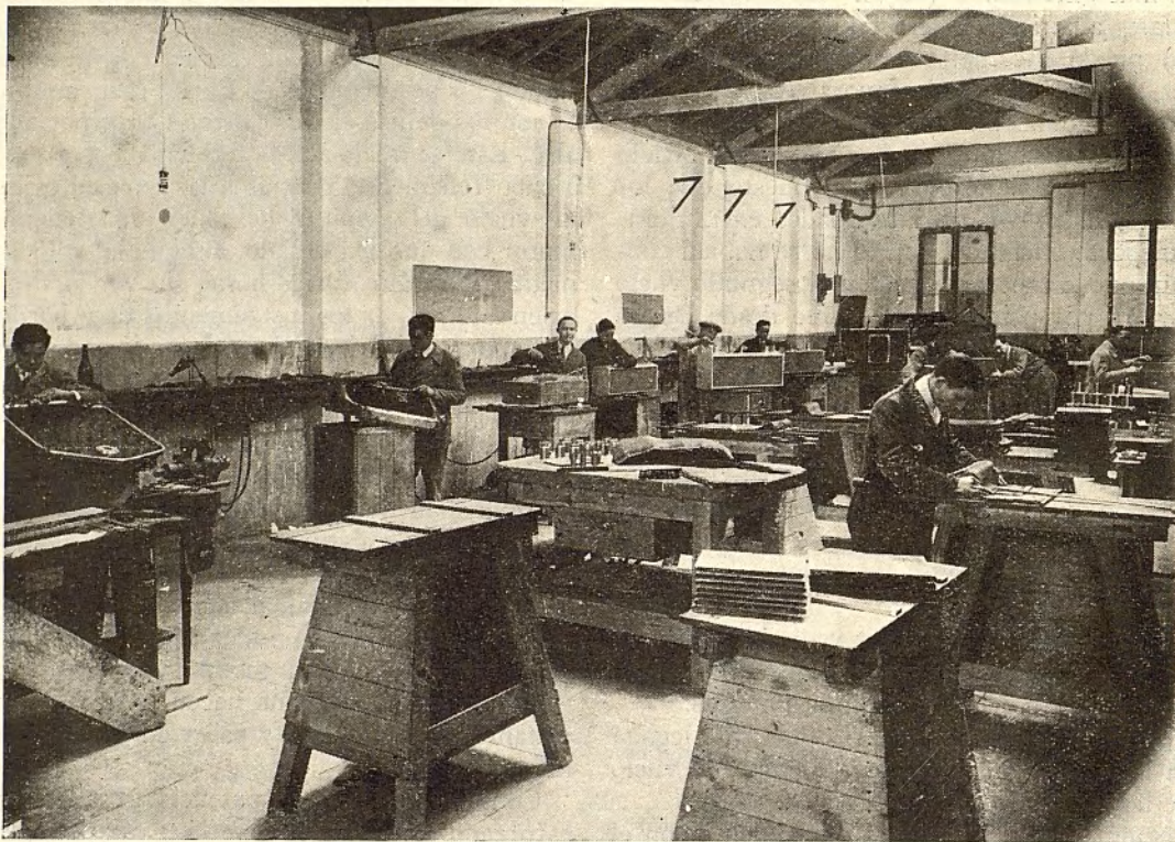
Vista parcial del taller donde se fabrican los radiadores
