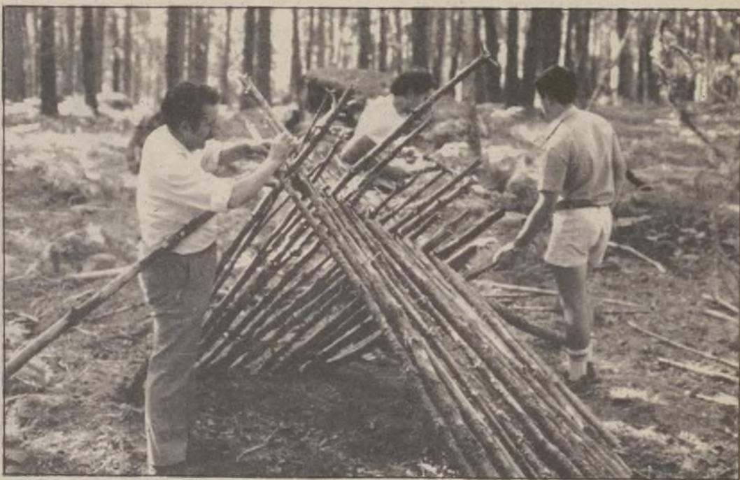
Construcción de un refugio.
