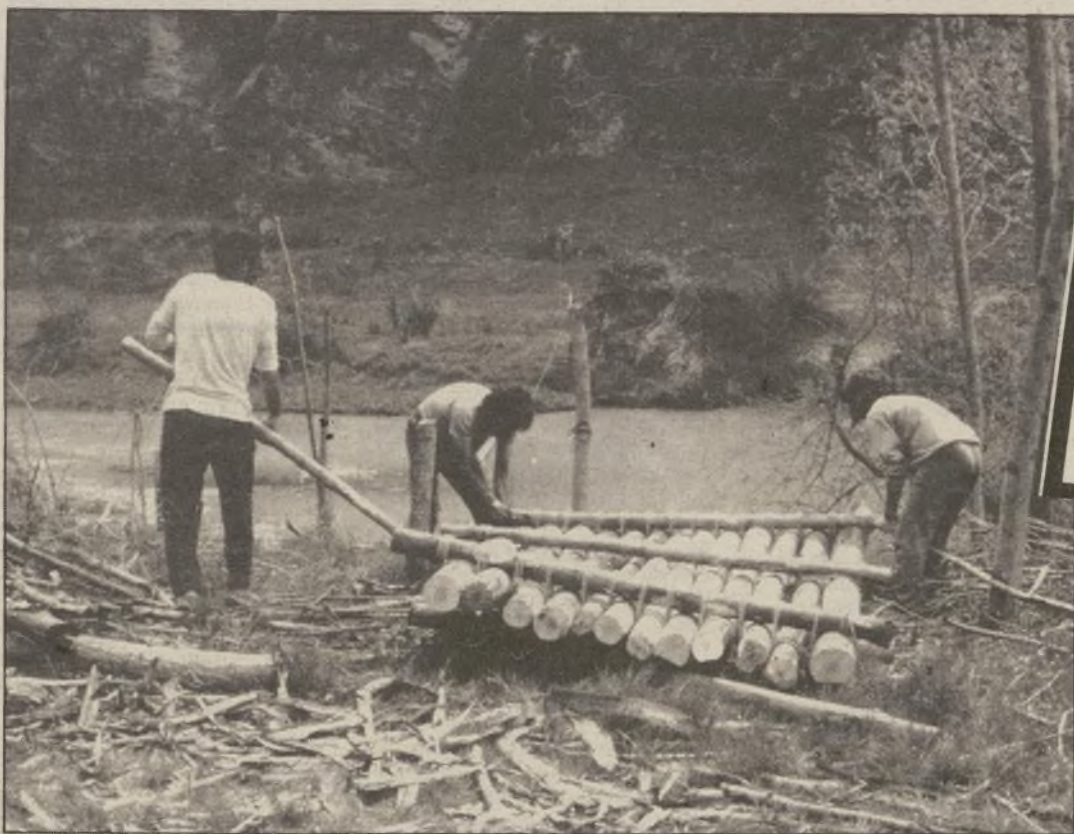
Construcción de una balsa.
